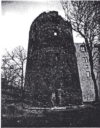
Abb.2: Moritzburg Halle, West-Turm. Links: Großformatige Vorlage, gescannt mit Kodak PhotoCD Pro (Auflösung 4096 x 6144 Pixel), rechts: Bildplan der Abwicklung (etwa 270°), bestehend aus sieben einzeln entzerrten Aufnahmen.
