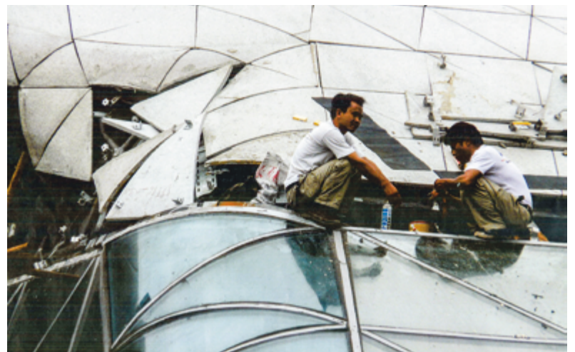
Abb. 3: Baustelle des Opernhauses in Guangzhou, 2010, Zaha Hadid
