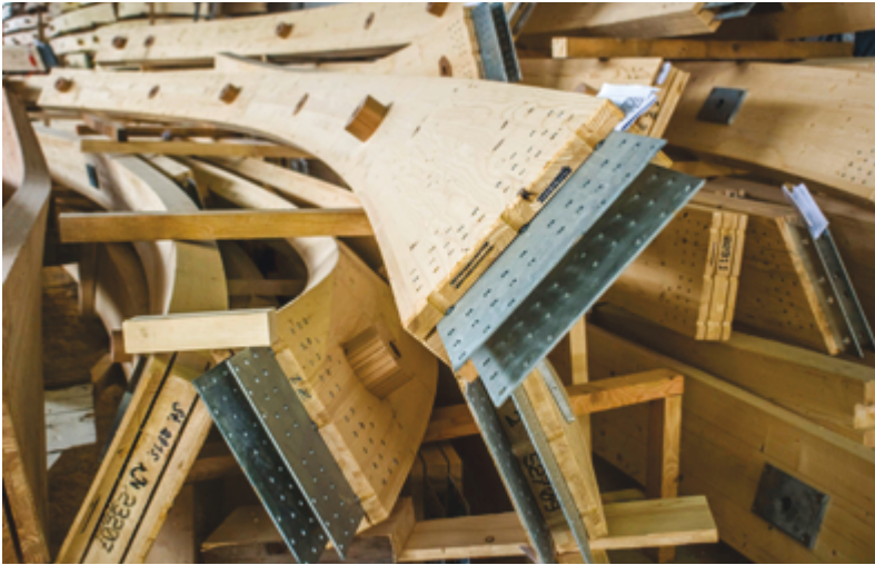
Abb. 4: Digital fabriziertes Bauteil für die Errichtung des Centre Pompidou in Metz
