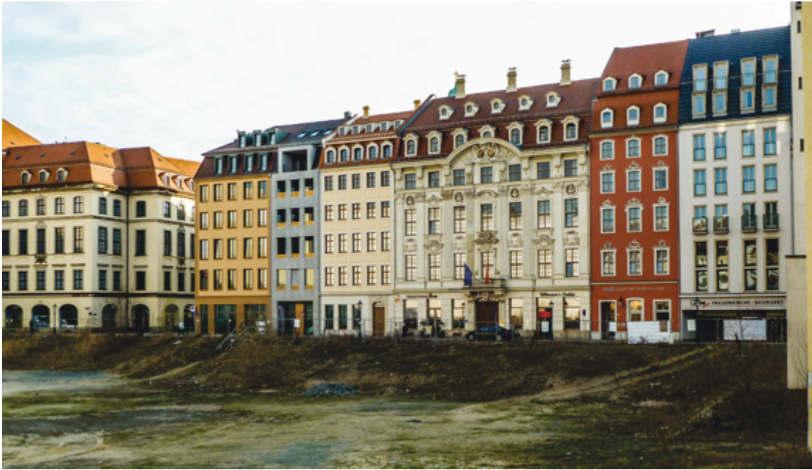
Abb. 1: Dresden, Neubebauung an der Landhausstraße, 2017
