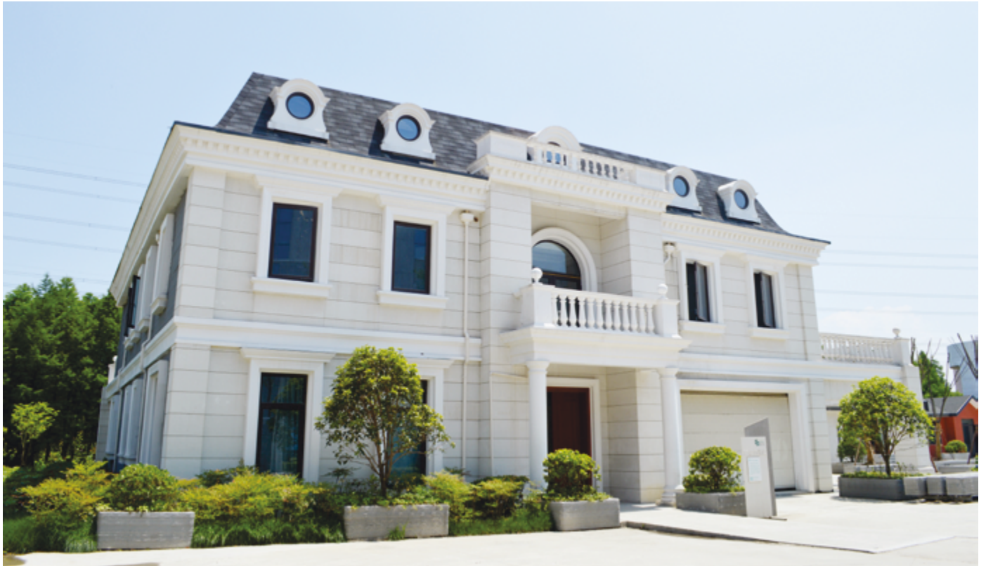
Abb. 9: Im 3D-Druck Verfahren hergestelltes Haus
