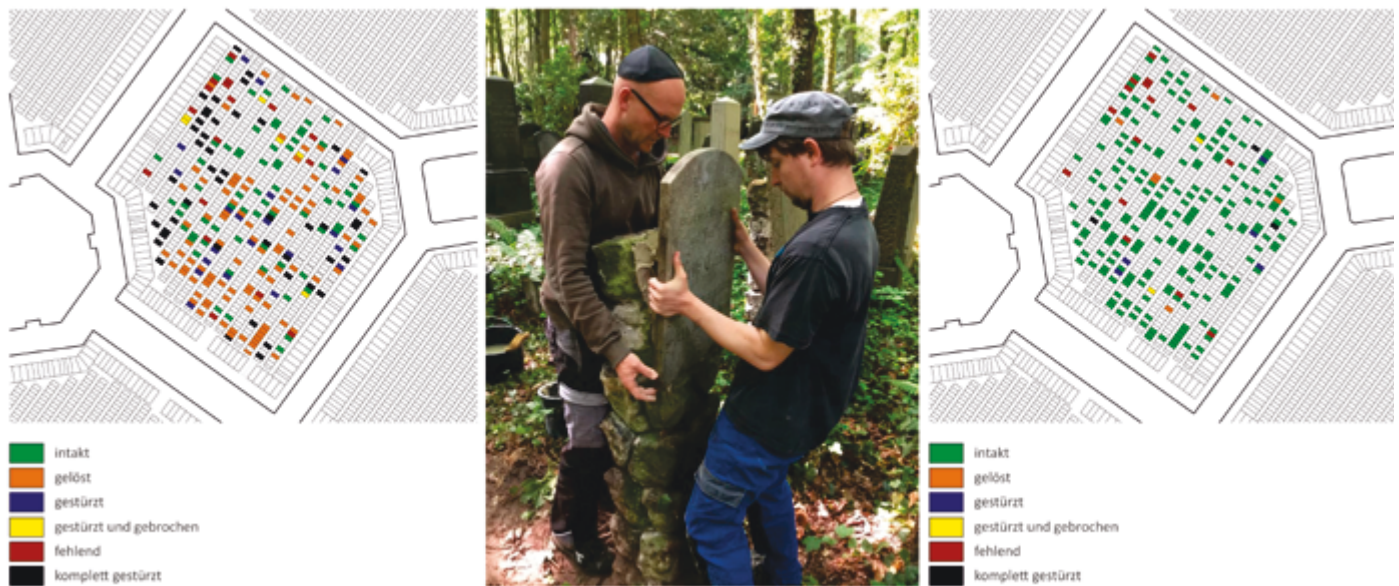
Abb. 2: Jüdischer Friedhof Berlin-Weißensee, Grabfeld R2; Zustand von Schriftplatten sogenannter Pultsteine vor (links), während (Mitte) und nach (rechts) Instandsetzungsmaßnahmen. Die Datengrundlage liefert verlässliche Grundlagen für die zielgerichtete denkmalpflegerische Erhaltung. Die Fortschreibbarkeit der Daten gewährleistet langfristiges Monitoring. (2015)
