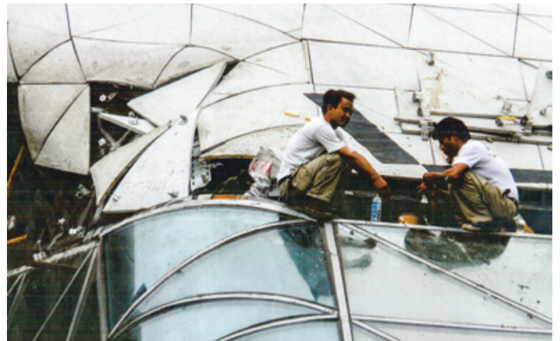
Abb. 3: Baustelle des Opernhauses in Guangzhou, 2010, Zaha Hadid
