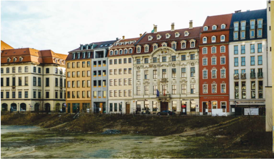
Abb. 1: Dresden, Neubebauung an der Landhausstraße, 2017
