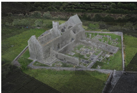
Abb. 7: Die Point Cloud der Corcomroe Abbey (Dronenaufnahmen)
