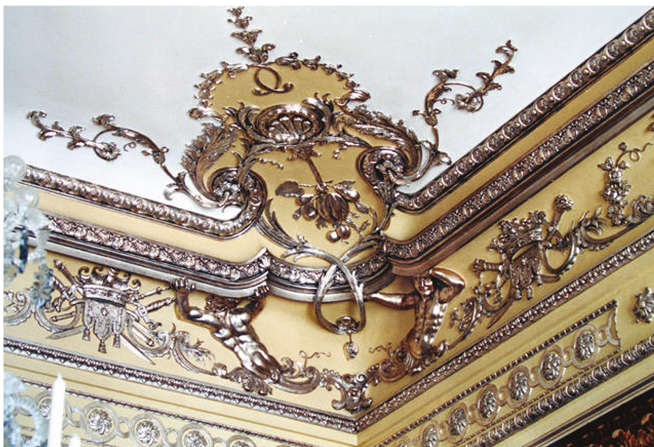
4 Wurtzbourg, château, Stucs de l'angle du plafond dans le Salon jaune du premier appartement de l'évêque, endommagés pendant la guerre, reconstruits avec les parties d'origine
