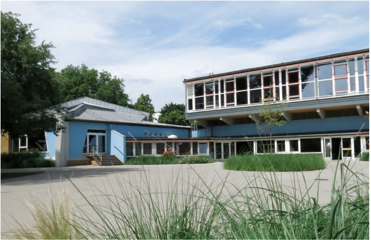
9 Scharoun, Hans, Geschwister-Scholl-Schule in Lünen/Westf., Blick vom Pausenhof auf das Schulgebäude. (2016)
