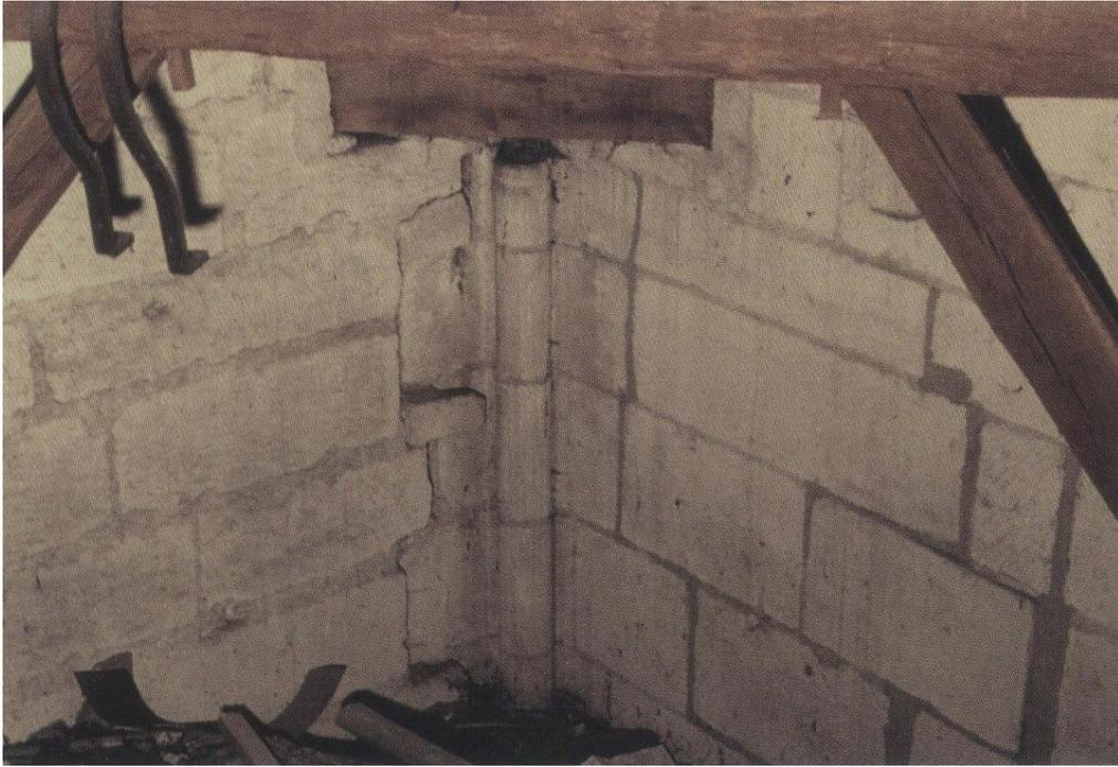
Abb. 52: Nordöstliche Ecke der Vierung vom Dachstuhl aus gesehen: unvollendeter Gewölbedienst
