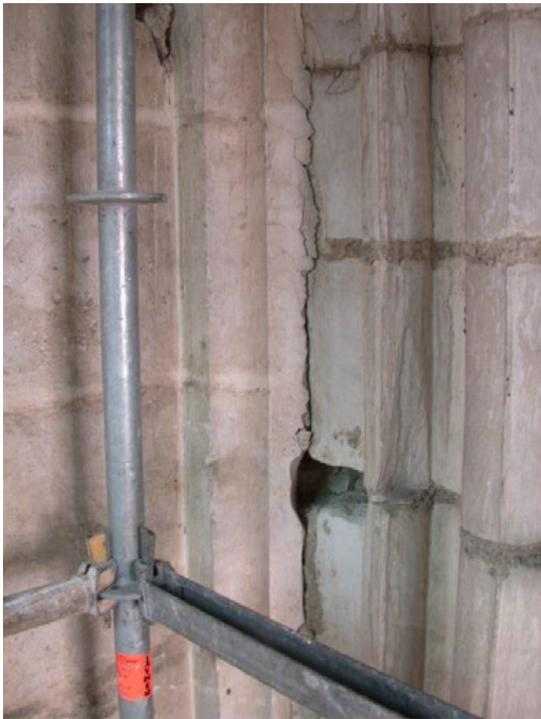
Abb. 64: Querhaus, Baunaht an der Nordseite
