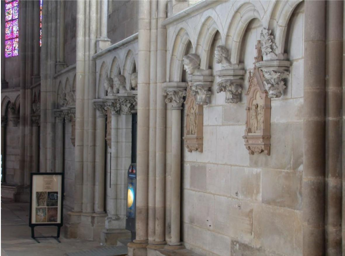
Abb. 125: Kopfkonsolen an der Sockelmauer des Chorumgangs, Südseite
