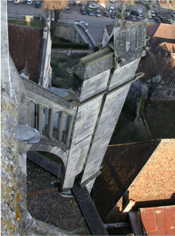
Abb. 90: Strebepfeiler des Chores, Wasserableitungssystem
