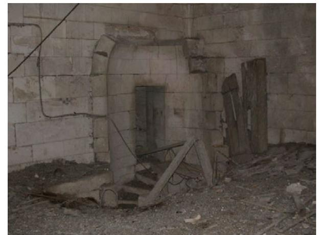
Abb. 99: Südturm, Treppenspindel
