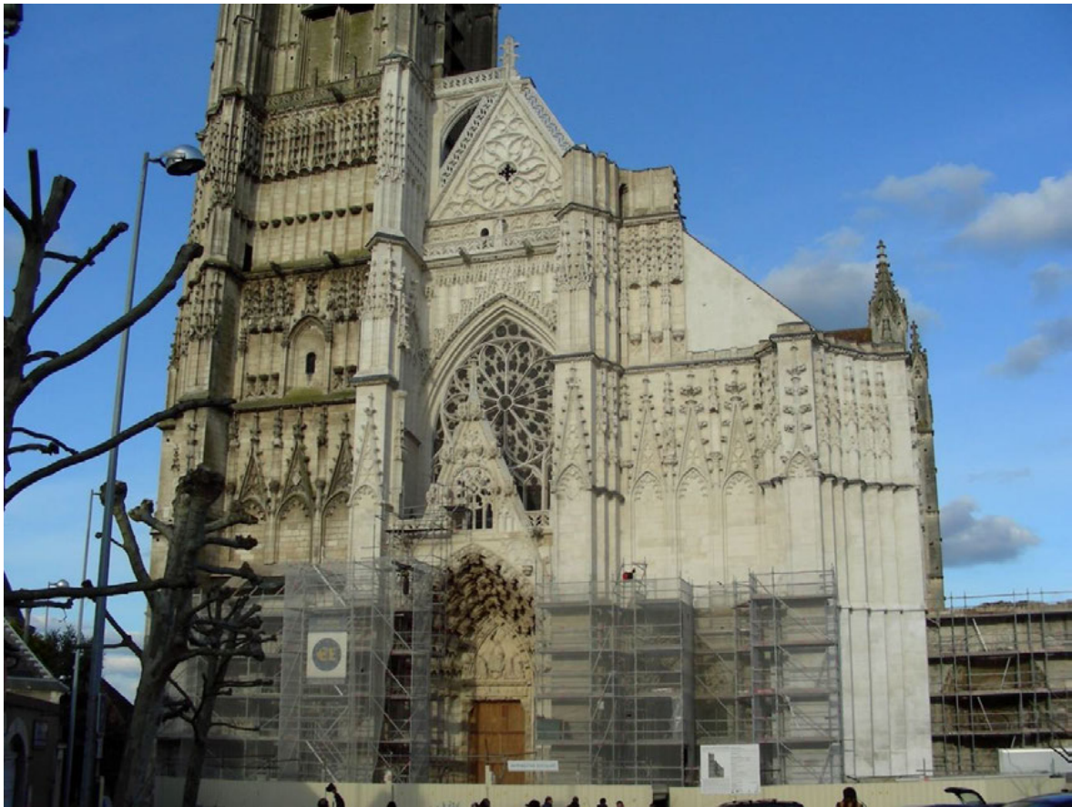
Abb. 38: Westfassade im März 2008, während der Restaurierungsarbeiten
