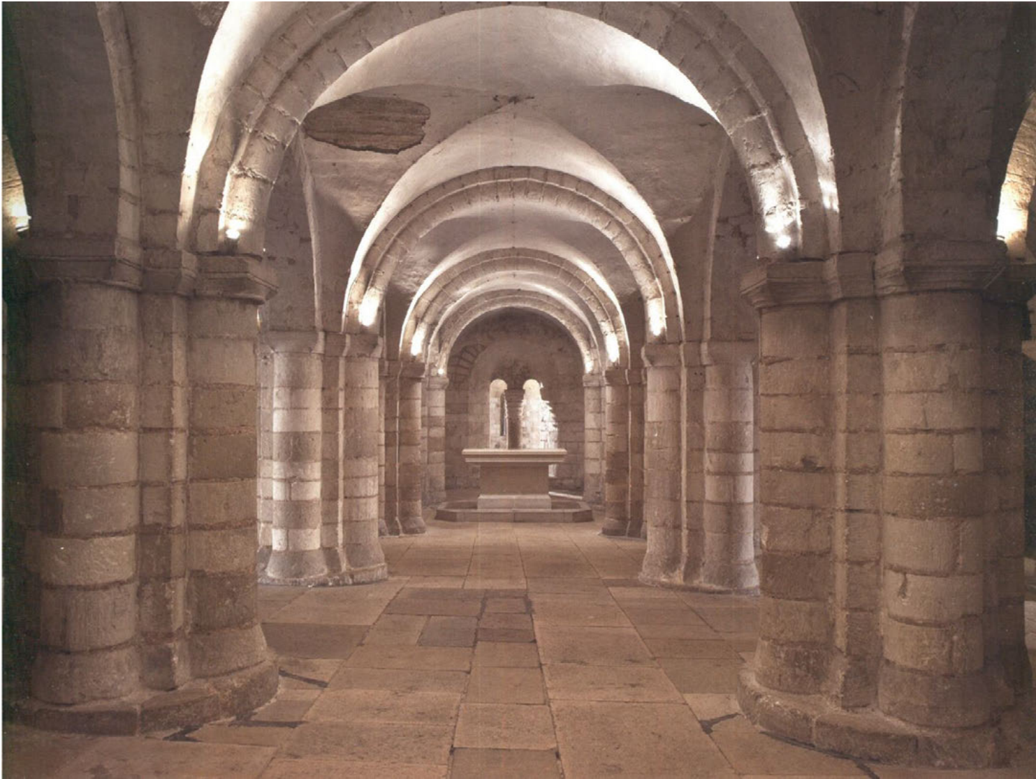
Abb. 100: Gesamtansicht der Krypta mit Blick in Richtung Osten
