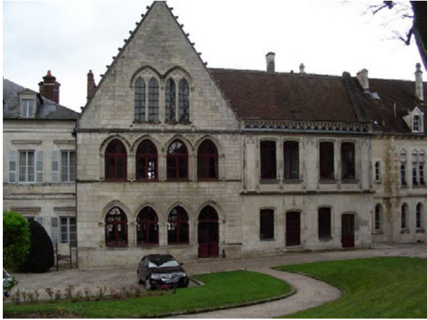
Abb. 22: Front des ehem. Bischofspalastes
