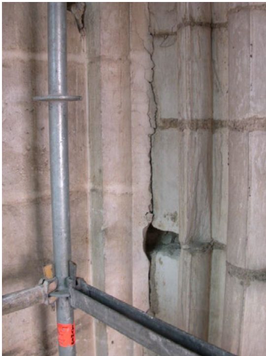
Abb. 64: Querhaus, Baunaht an der Nordseite
