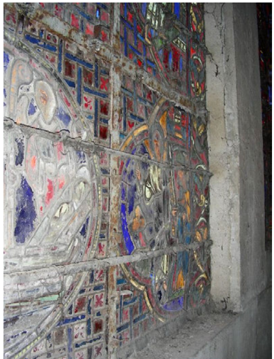
Abb. 163: Detail des Fensters 16, mit Blitzlicht fotogr.
