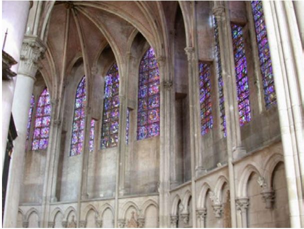
Abb. 54: Nördlicher Chorungang, Sockelmauer
