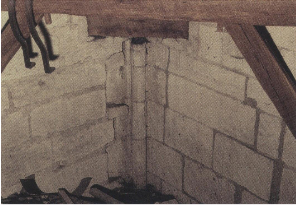
Abb. 52: Nordöstliche Ecke der Vierung vom Dachstuhl aus gesehen: unvollendeter Gewölbedienst
