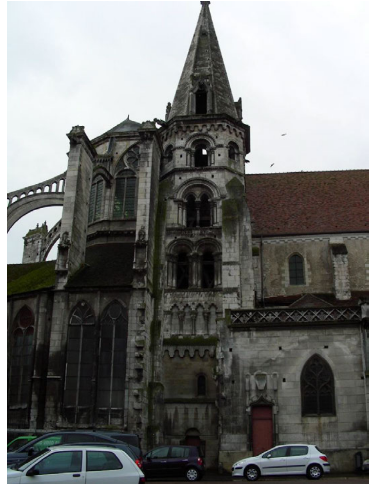
Abb. 18: Saint-Eusèbe, Turm des 12. Jh.
