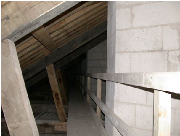
Abb. 80: Dachstuhl des nördlichen Seitenschiffs
