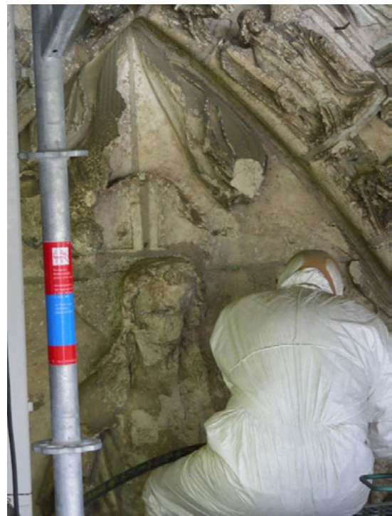
Abb. 40: Restaurierungsarbeiten an der Westfassade
