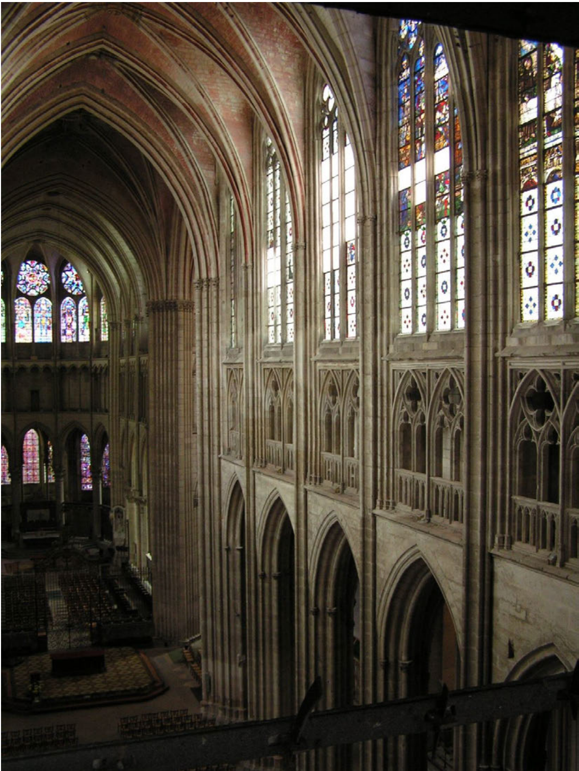
Abb. 46: Blick in das Mittelschiff in Richtung Osten
