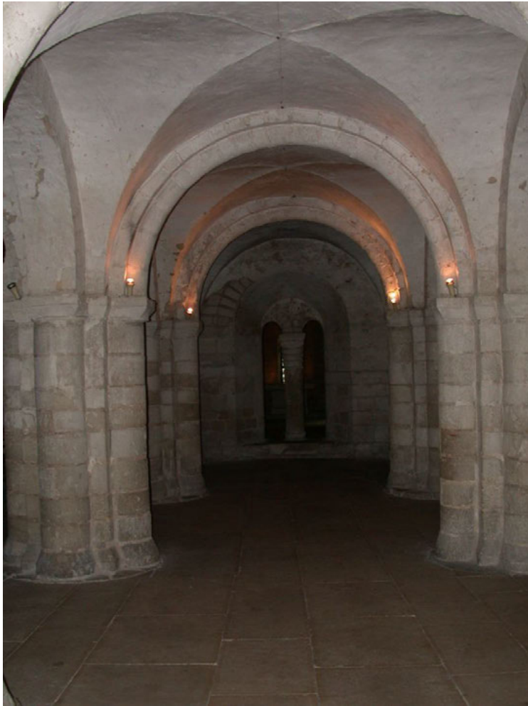
Abb. 101: Mittelschiff der Krypta, Blick in Richtung Osten
