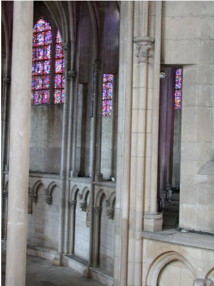
Abb. 57: Laufgang des Chorumgangs, Nordseite
