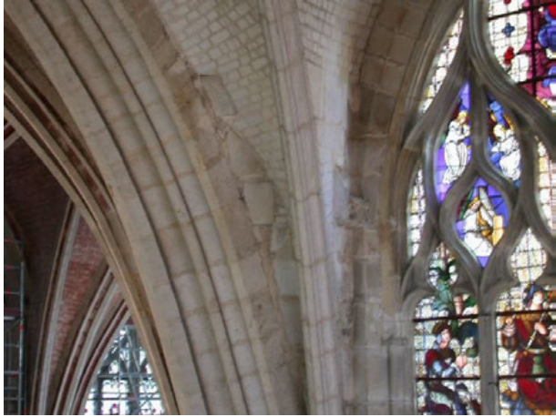
Abb. 75: Querhaus, Nordwestseite, Gewölbeanfänger
