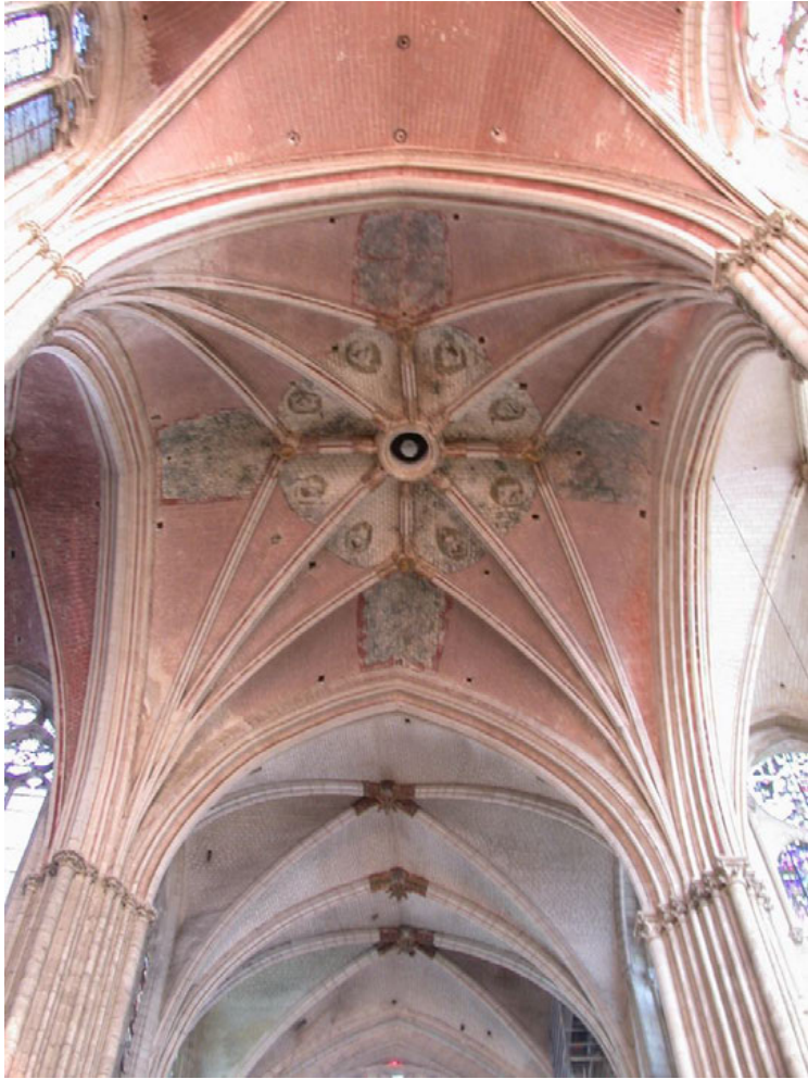
Abb. 69: Gewölbe der Vierung
