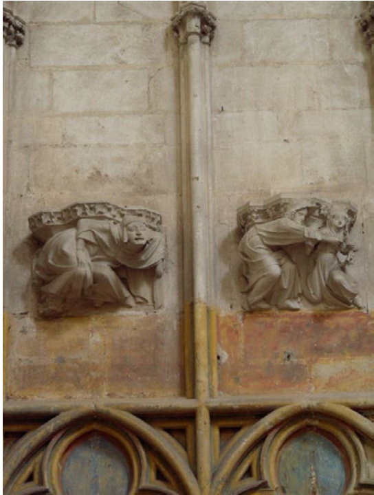
Abb. 128: Südwand des Querhauses, Figurenkonsolen
