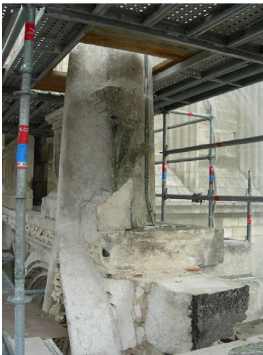
Abb. 39: Wartesteine am Giebel der Westfassade
