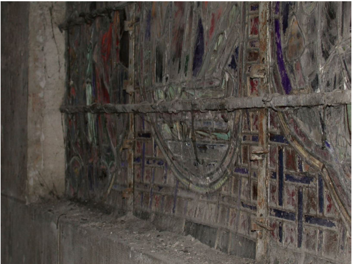
Abb. 165: Detail des Fensters 16, mit Blitzlicht fotogr.
