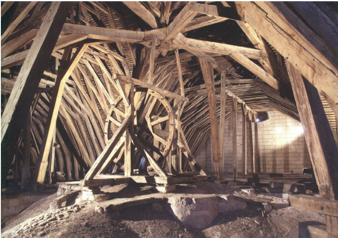
Abb. 84: Dachstuhl der Vierung und des südlichen Querhausarms
