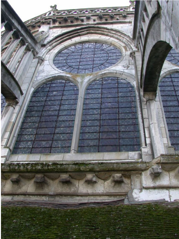
Abb. 88: Obergadenfenster des Chores, Nordseite
