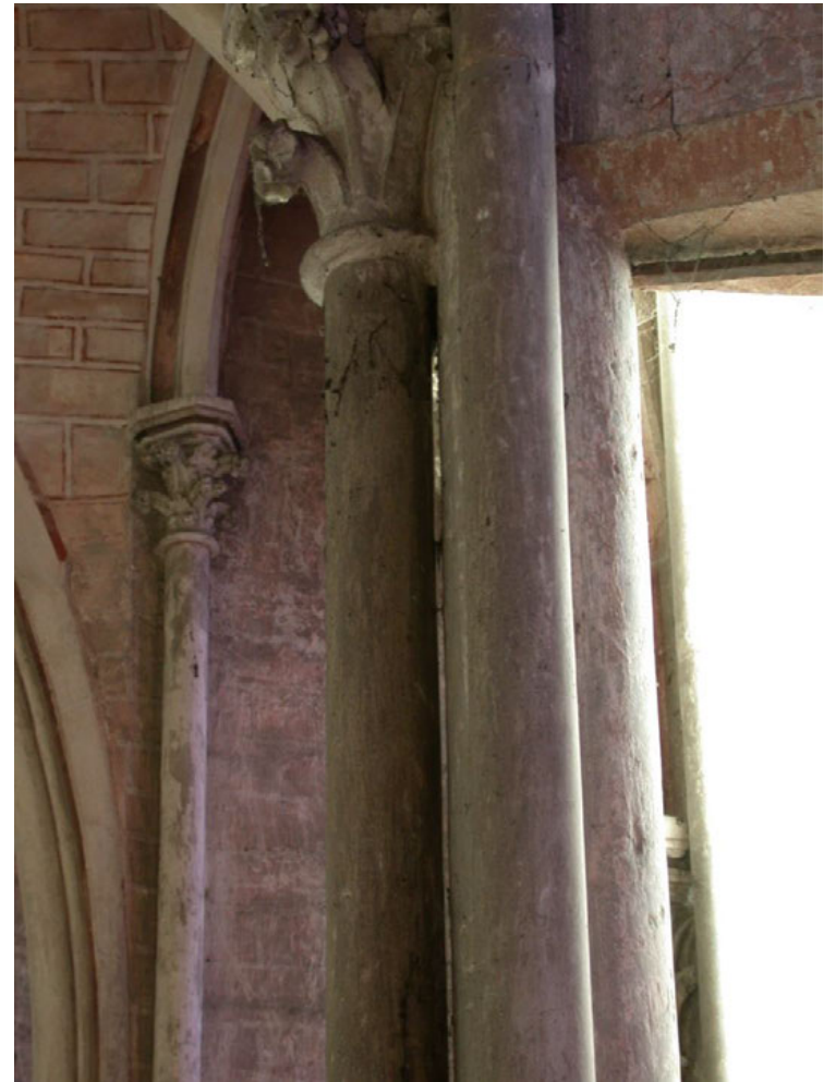
Abb. 58: En-délit Dienste des Chorumgangs, Südseite
