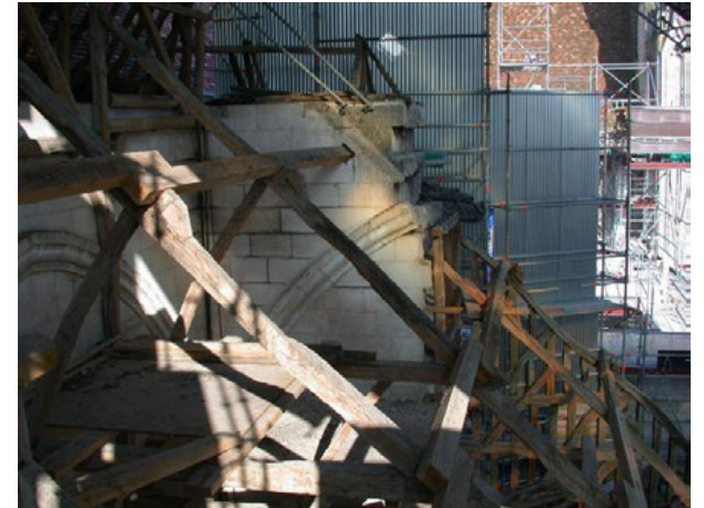
Abb. 97: Südturm, provisorisches Dach
