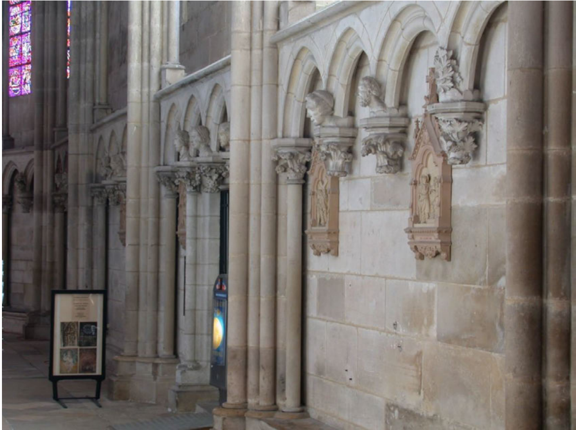
Abb. 125: Kopfkonsolen an der Sockelmauer des Chorumgangs, Südseite
