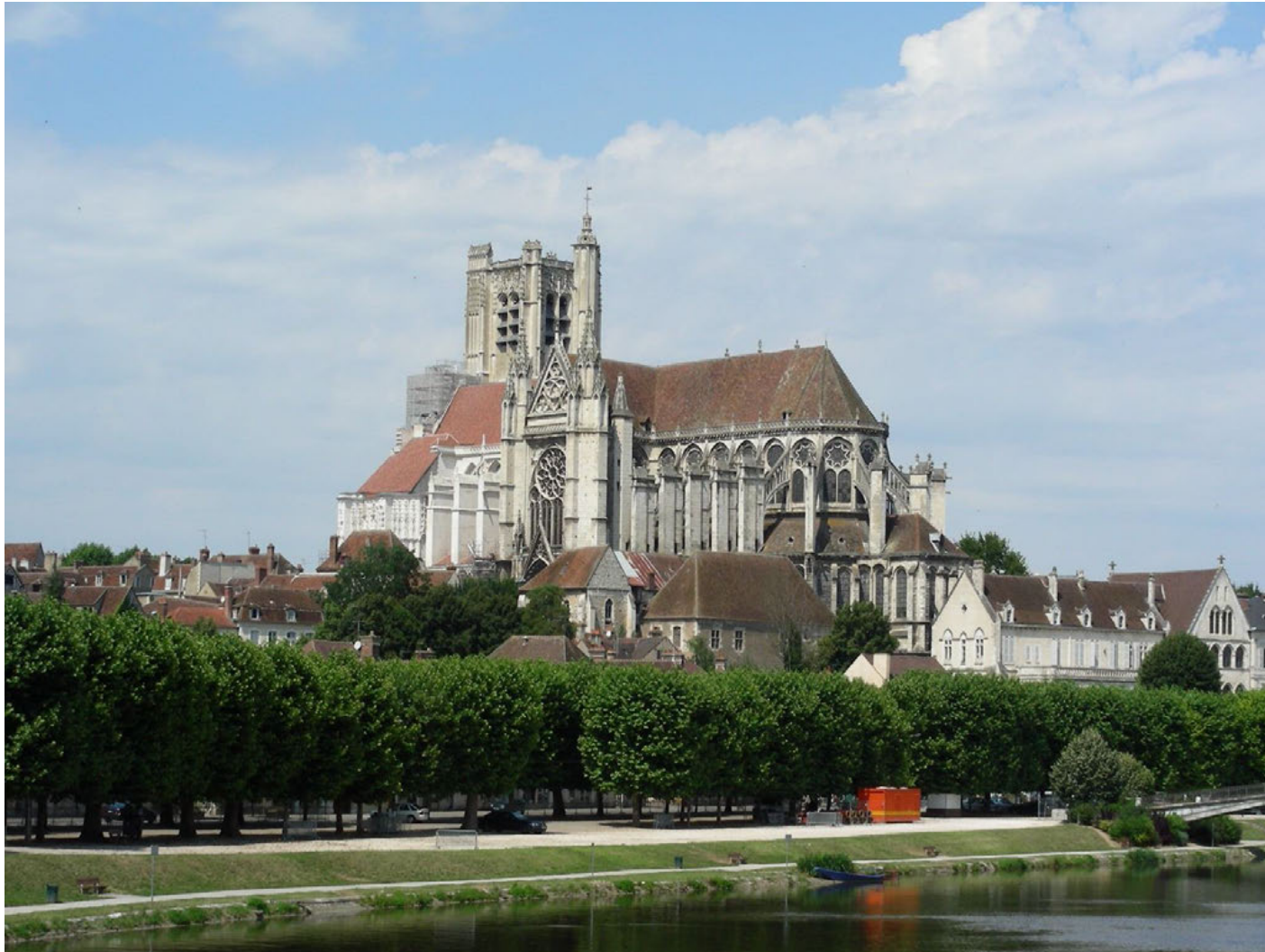
Abb. 30: Blick auf die Kathedrale Saint-Étienne vom Flussufer der Yonne
