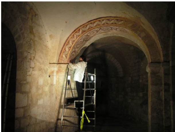
Abb. 136: Kartierung der Wandmalereien
