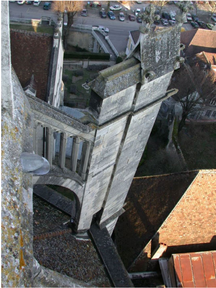
Abb. 90: Strebepfeiler des Chores, Wasserableitungssystem
