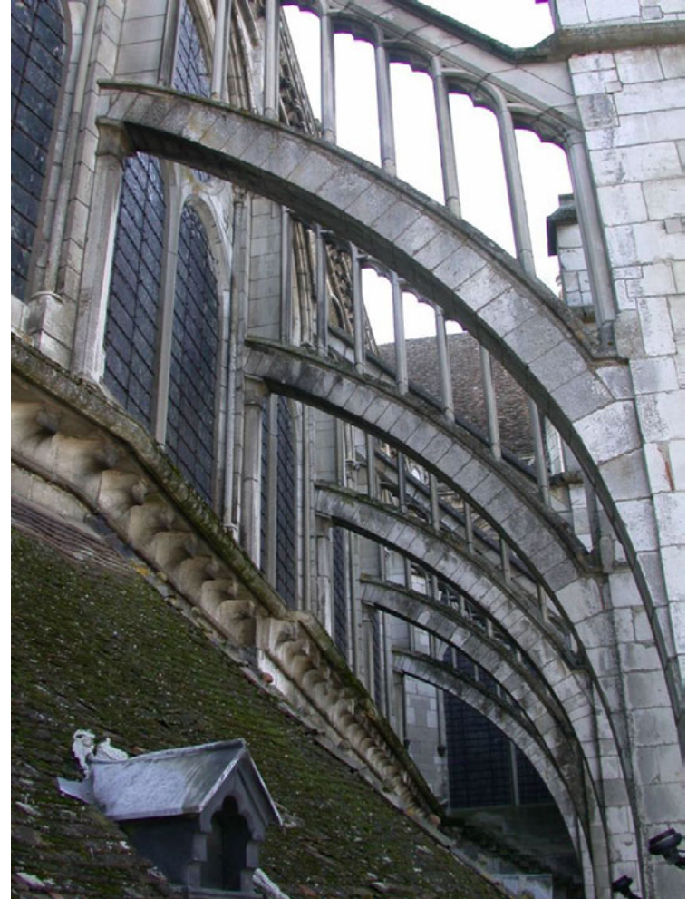
Abb. 89: Strebebögen des Chores, Nordseite
