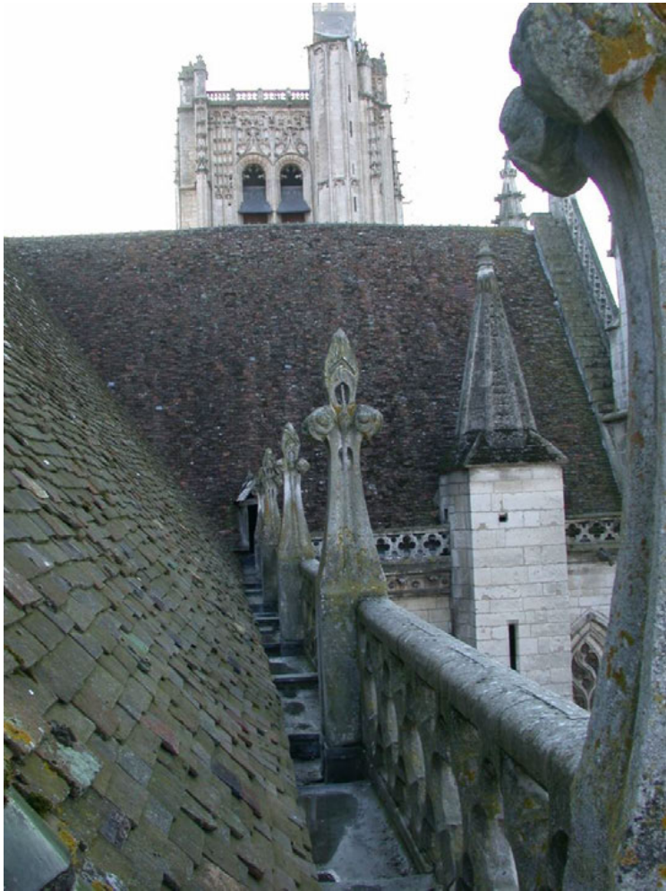
Abb. 86: Traufgesims des Chores, Nordseite
