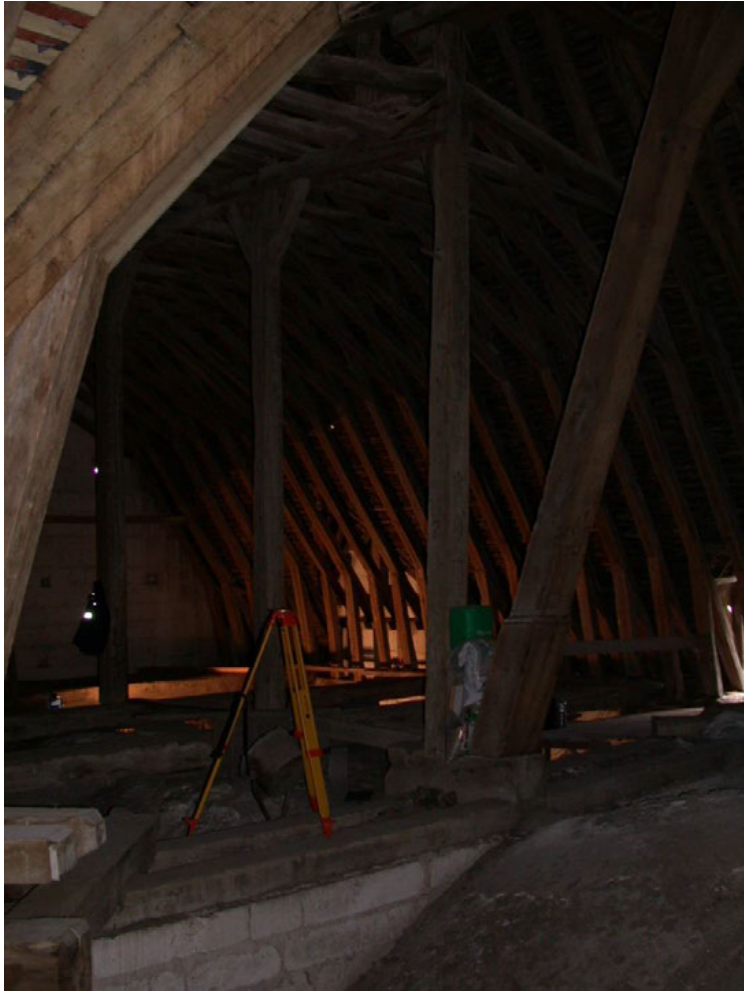
Abb. 73: Dachstuhl des Querhauses, Nordseite
