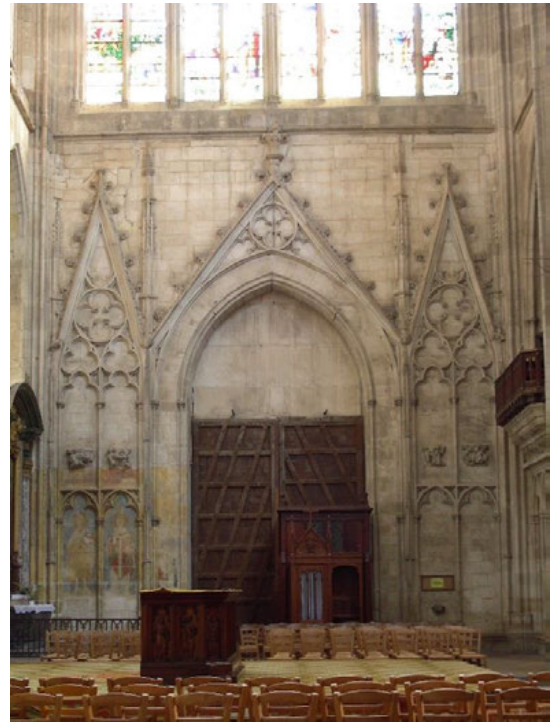
Abb. 63: Innenfassade des Südquerhausarms
