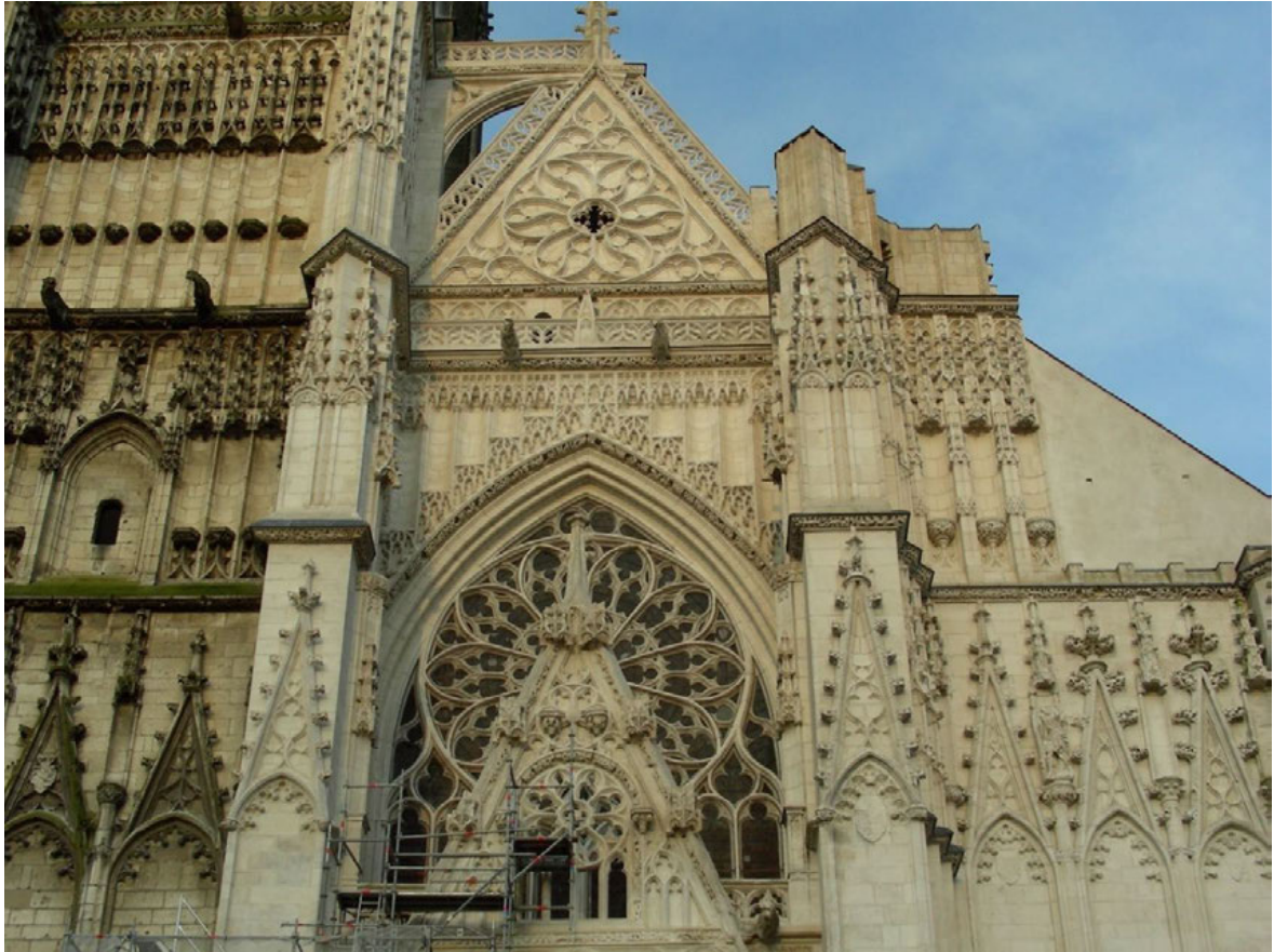
Abb. 119: Bauschmuck an den oberen Partien der Westfassade
