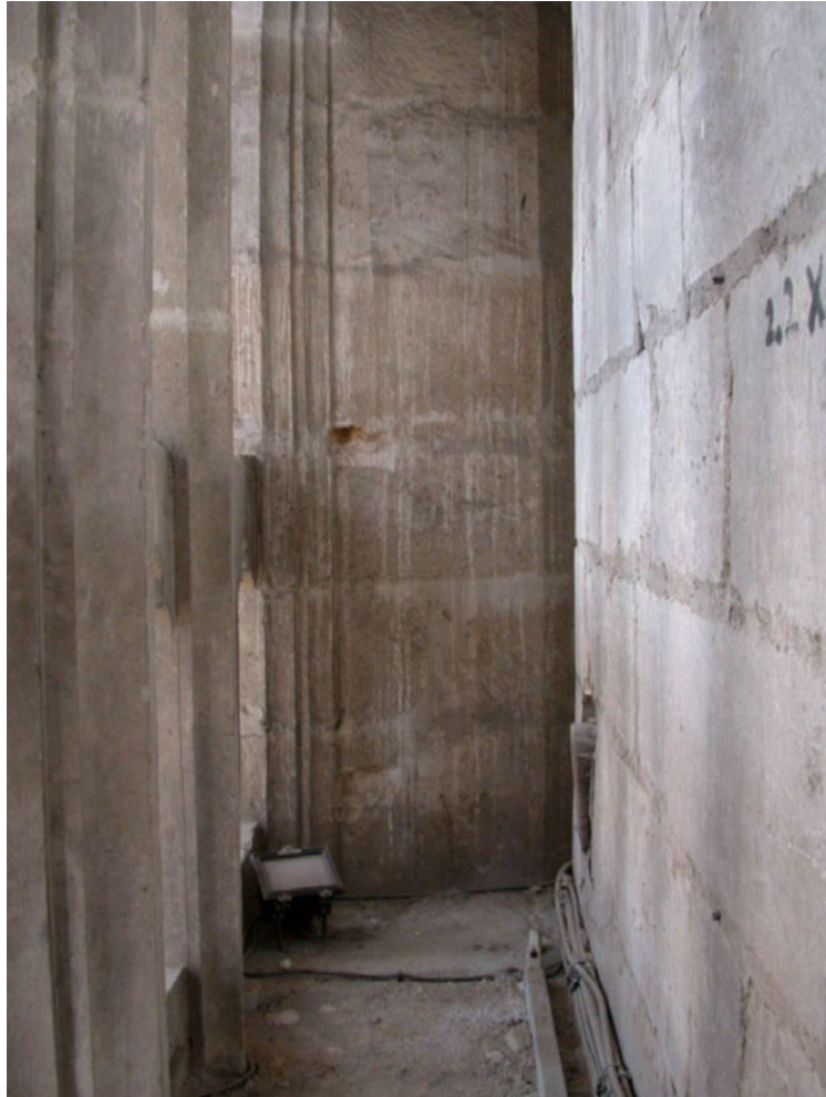
Abb. 82: Laufgang des Langhaustriforiums, Nordseite
