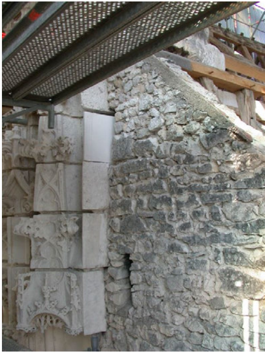
Abb. 92: Südturm, provisorische Wand
