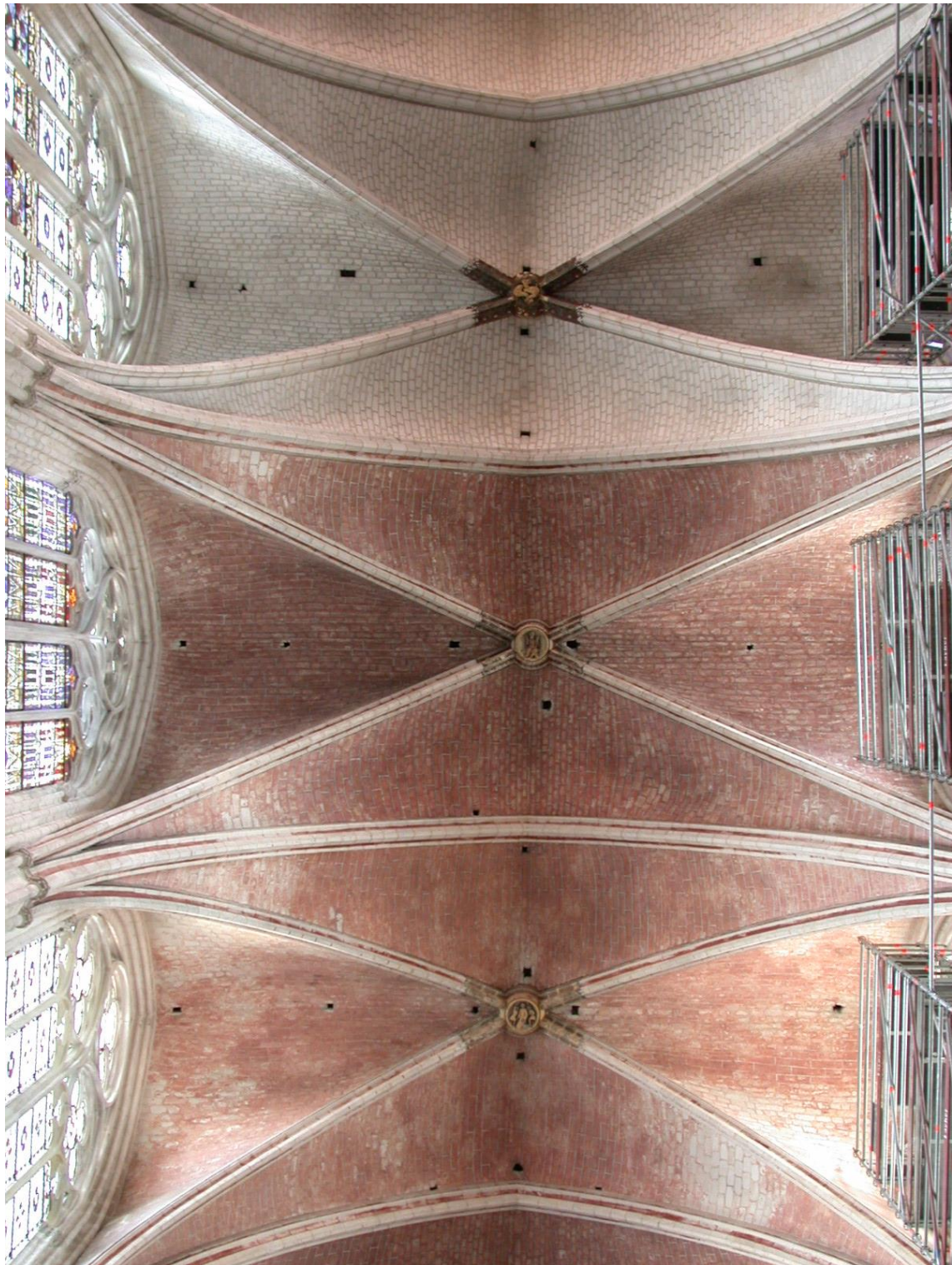
Abb. 68: Vierteilige Gewölbe des Langhauses
