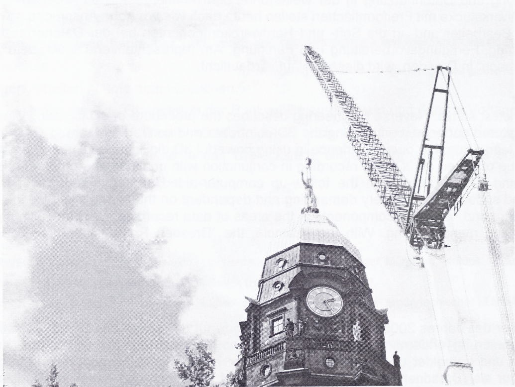
Abbildung 1: Der Goldene Rathausmann wird mit einem Kran von der Turmspitze gehoben
