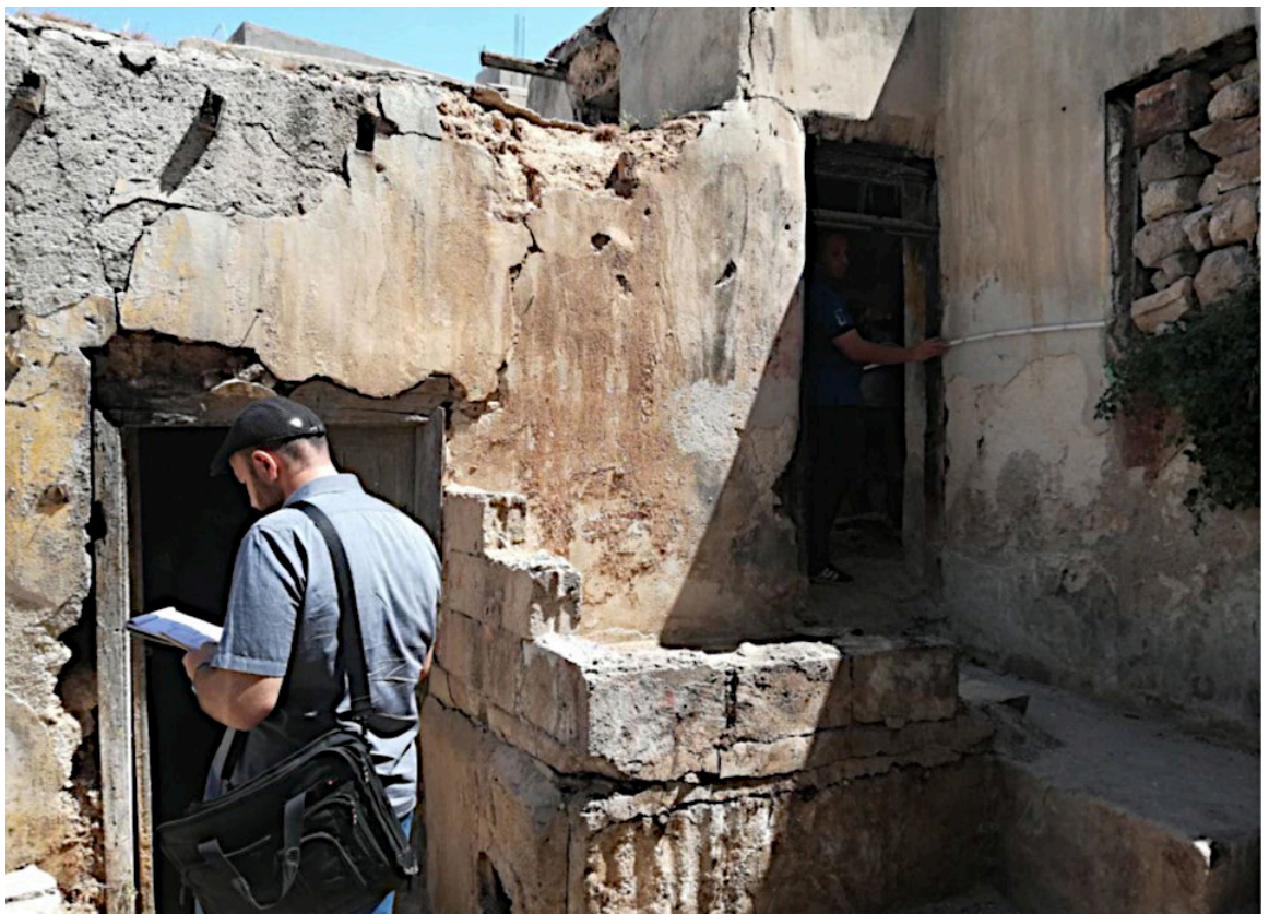
Abb. 3: Dokumentation eines Hofhaus in der Eisenbahnersiedlung der Hedschasbahn (2018).
