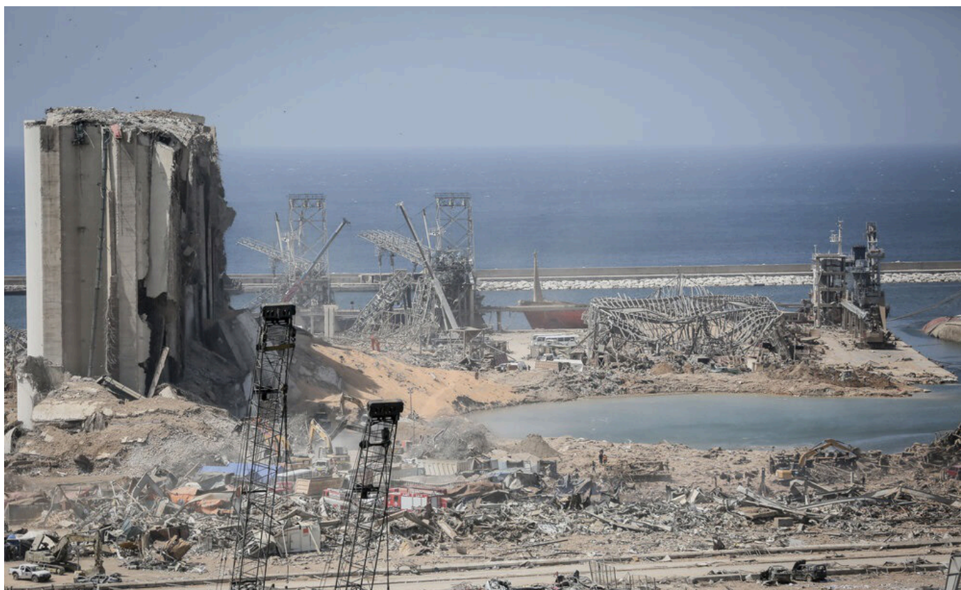
Abb. 1: „Damage after the Beirut explosion“
