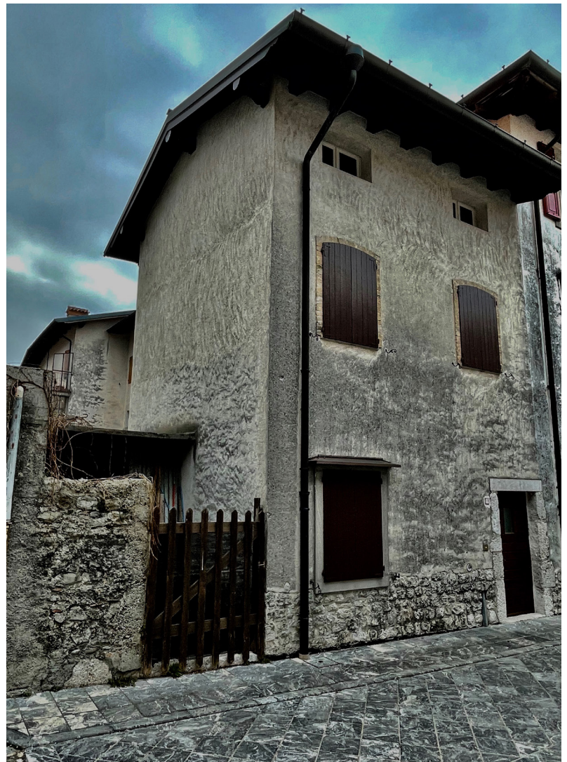
Abb. 2: Venzone, Piazza Municipio, traditioneller Kellenputz mit ortstypischer Patina an einem Ersatzbau (21.02.2023).
