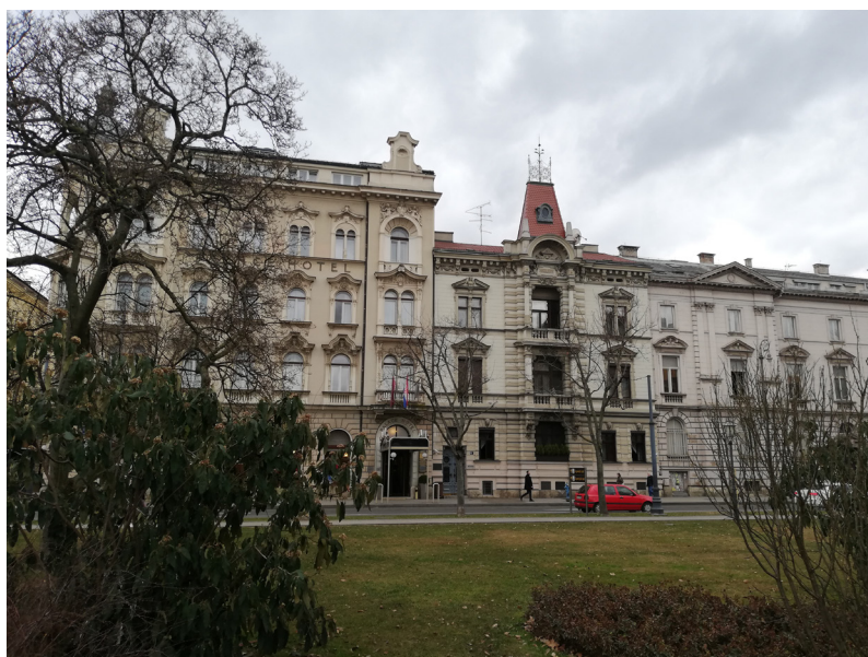
Abb. 3: Zagreb, Strossmayerplatz. Foto: Irena Kraševac (2020).
