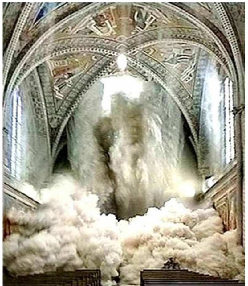
Abb. 3: Still aus dem zufällig gefilmten Einsturz des Gewölbes der Oberkirche von San Francesco in Assisi am 26. September 1997.
