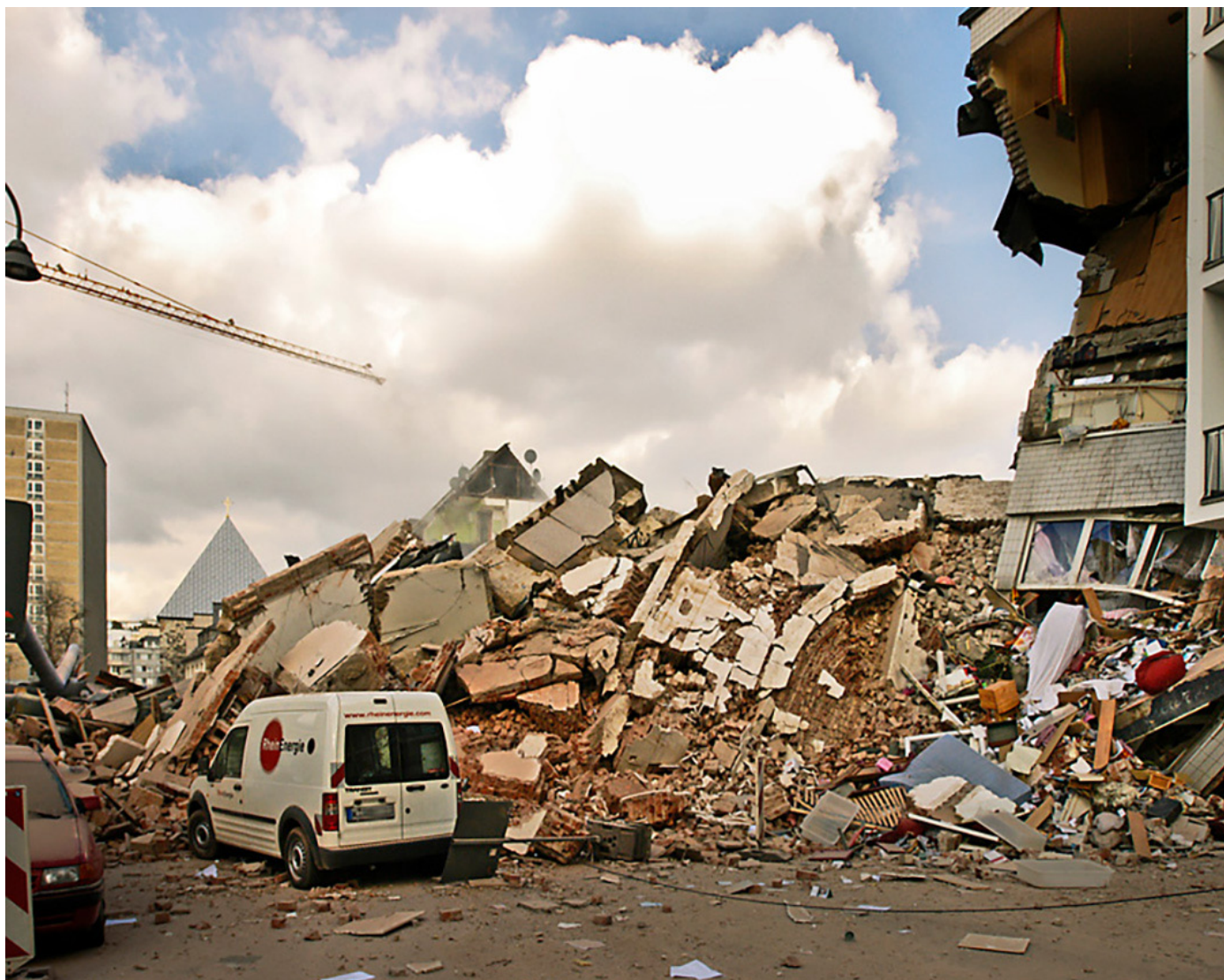
Abb. 4: Die Trümmer des Kölner Stadtarchivs unmittelbar nach dem Einsturz am 11. April 2009.
