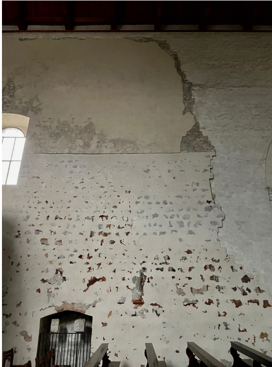
Abb. 3: Venzone, Dom, Wandmalerei des 15. Jahrhunderts an der eingestürzten Nordwand nach der baulichen Anastylose und folgenden Freilegung bzw. Konservierung / Restaurierung (21.02.2023).
