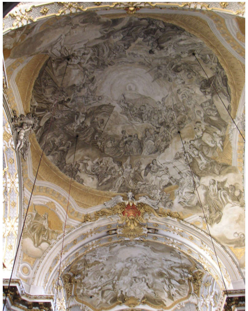
Abb. 4: München, Damenstiftskirche, Cosmas Damian Asam 1733-35, Kriegszerstörung 1944, Wiederherstellung von Karl Manninger.
