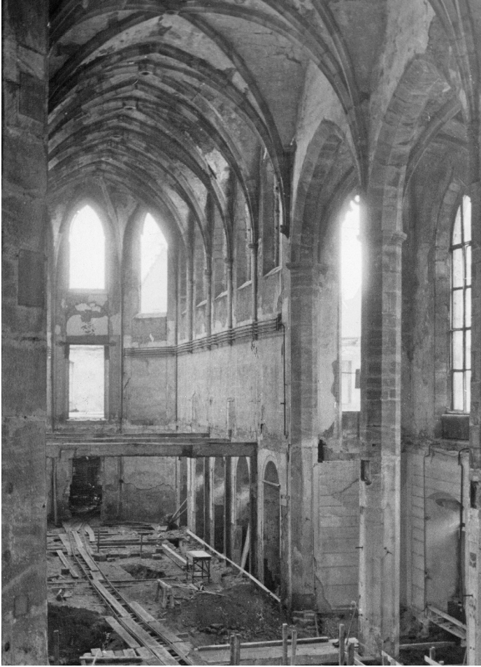
Abb. 12 Blick in den Chor der Paulinerkirche während der Wiederherstellung nach den Bombenschäden von 1944
