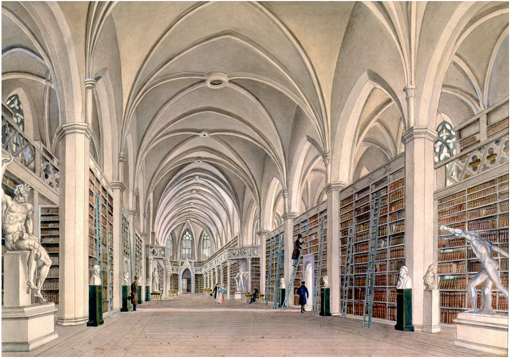
Abb. 5 Der Historische Saal im Obergeschoss der Paulinerkirche nach dem Umbau 1812, lavierte Federzeichnung
