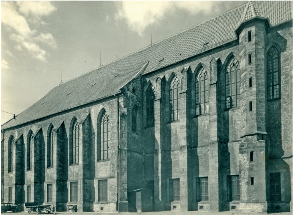
Abb. 1 Ansicht der Göttinger Paulinerkirche von Südosten, im Vordergrund unten die Fenster des ehemaligen Antikensaals, Aufnahme um 1930
