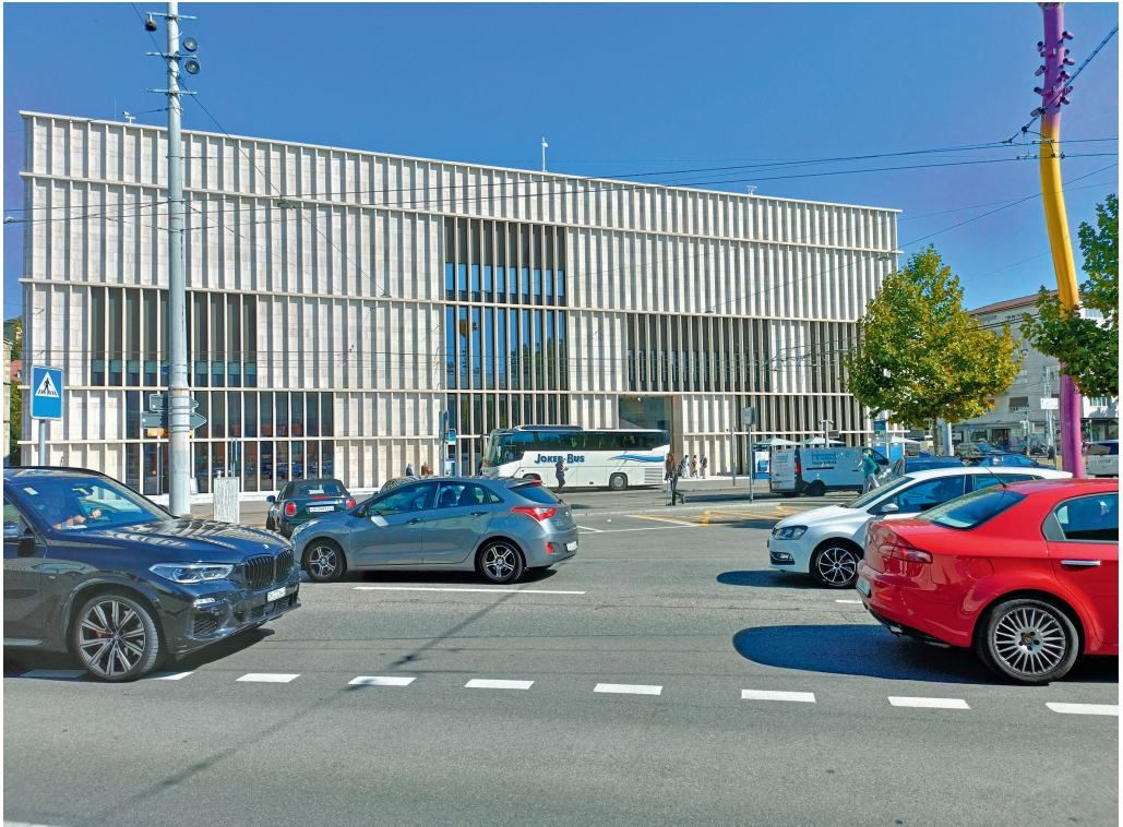
Abb. 4 Kunsthaus Zürich, Chipperfield-Bau, Situation am Heimplatz
