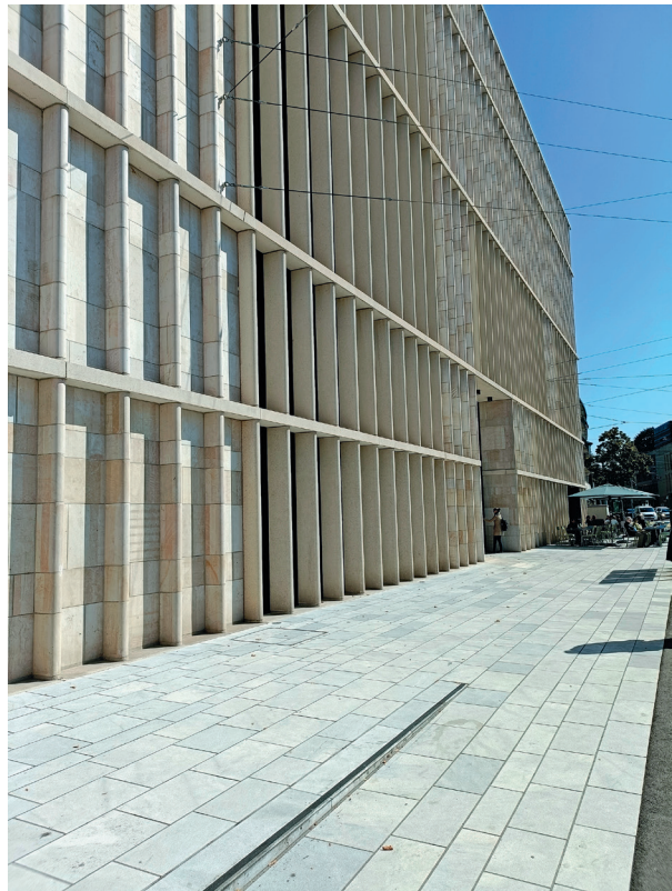
Abb. 8 Kunsthaus Zürich, Chipperfield-Bau, Eingangsfront zum Heimplatz
