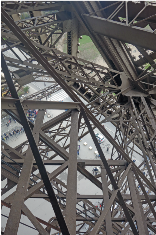
Abb. 4 Detail des Eisenfachwerks des Eiffelturms, Digitalfotografie 2016
