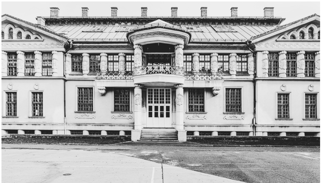
Abb. 2: Ansicht parkseitige Westfassade.
