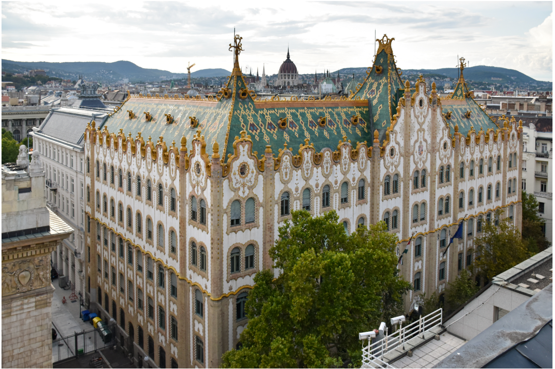
Abb. 1: Ödön Lechner: Postsparkasse Budapest, 1912, Gesamtansicht.
