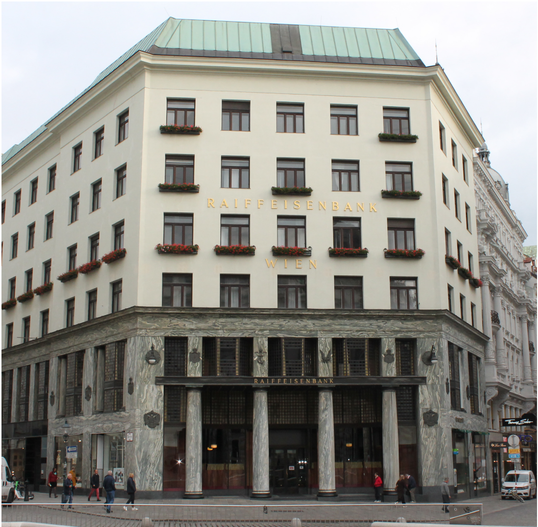
Abb. 1: Adolf Loos: Haus am Michaelerplatz, 1911, Hauptfassade zum Michaelerplatz.
