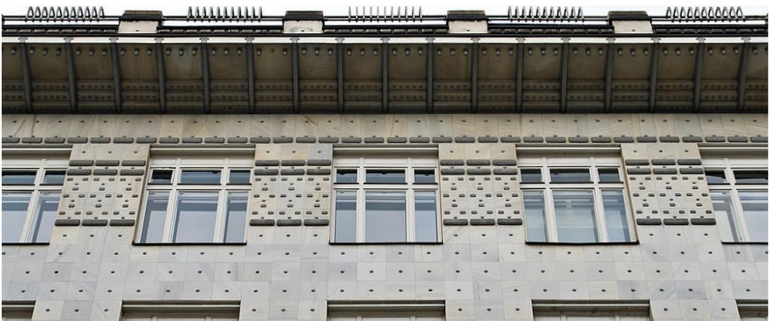
Abb. 3: Fassadengestaltung mit Bolzen und Kranzgesims.
