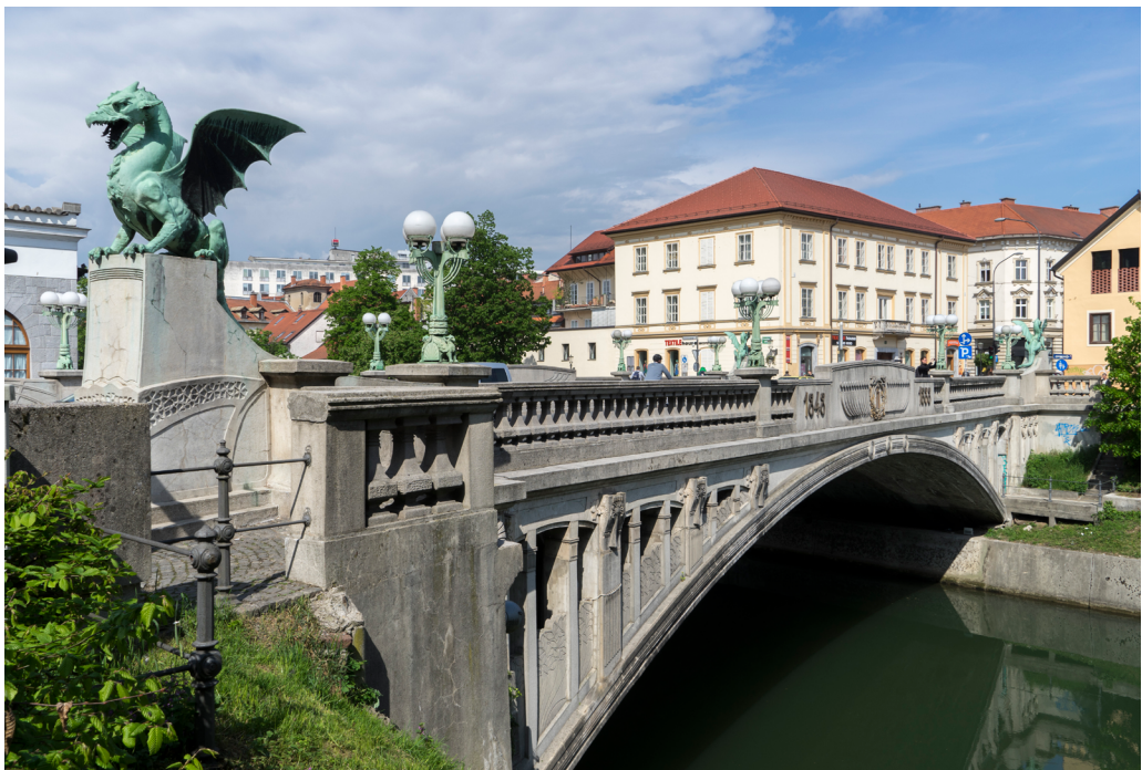
Abb. 17: Ljubljana, Kaiser Franz Josef I. Jubiläumsbrücke, aktueller Zustand.
