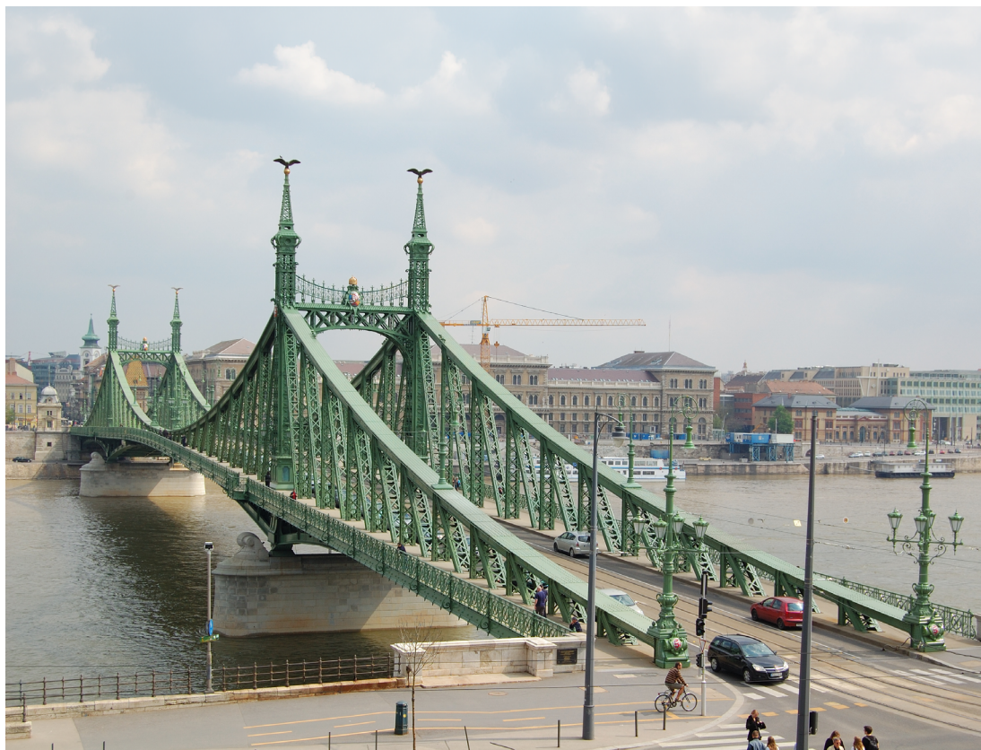
Abb. 16: Budapest, Franz-Josefs-Brücke mit Strompfeilern, Oberbau, Pylonen und Kandelabern, aktueller Zustand.
