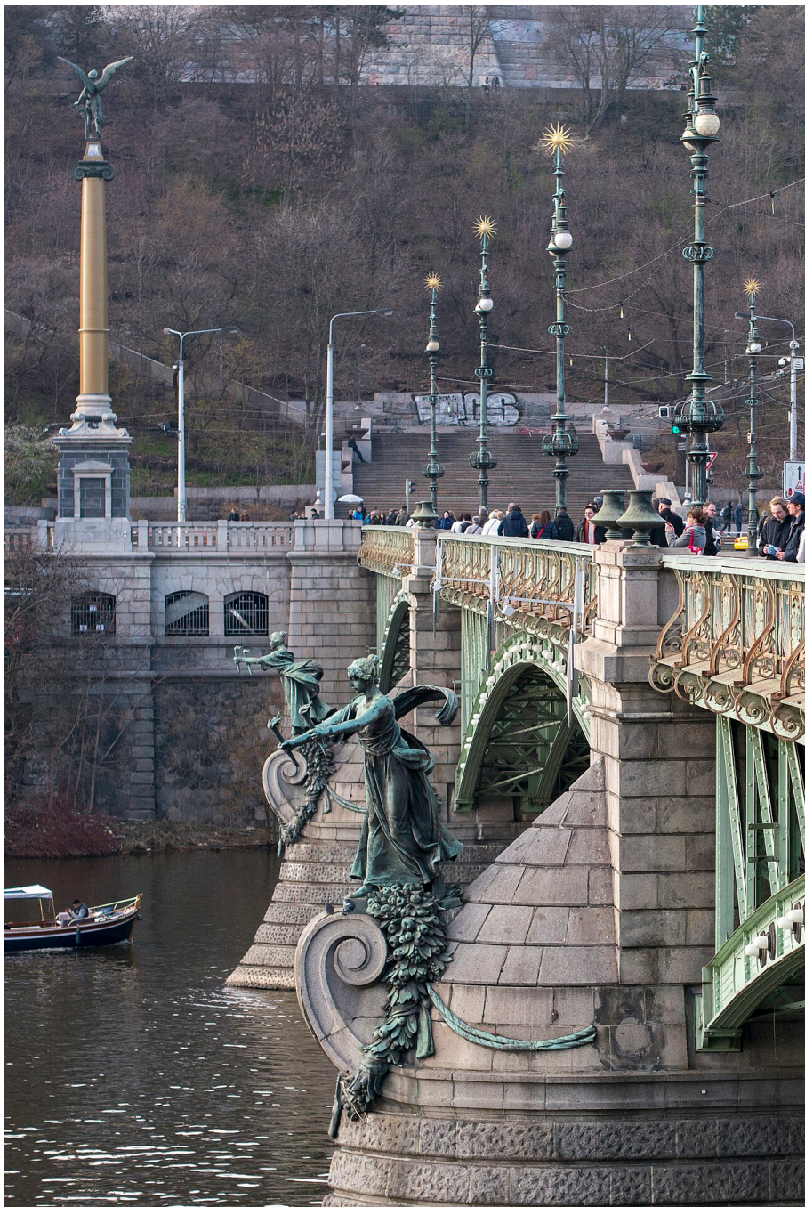
Abb. 9: Most Svatopluka Čecha (heute Čechův most), westliche Brückenfassade, aktueller Zustand.
