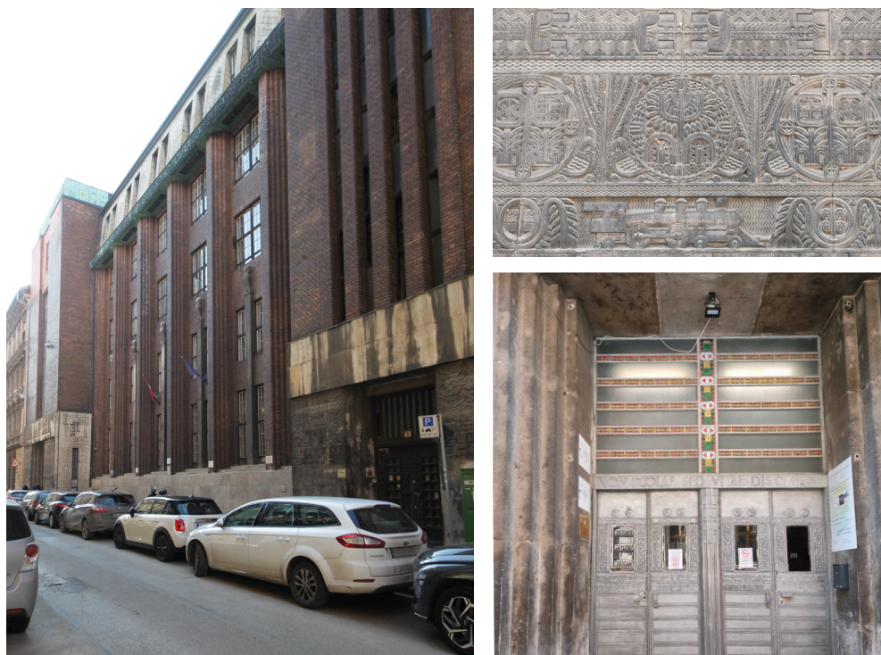
Abb. 15–17: Béla Lajta: Hauptstädtische Handelsschule (heute BGSZC Széchenyi István Kereskedelmi Technikum), 1909–13, Straßenfassade, Fassadendetails und trichterförmiges Eingangsportal mit Inschrift „Non Scolae sed vitae discimus“, aktueller Zustand.
