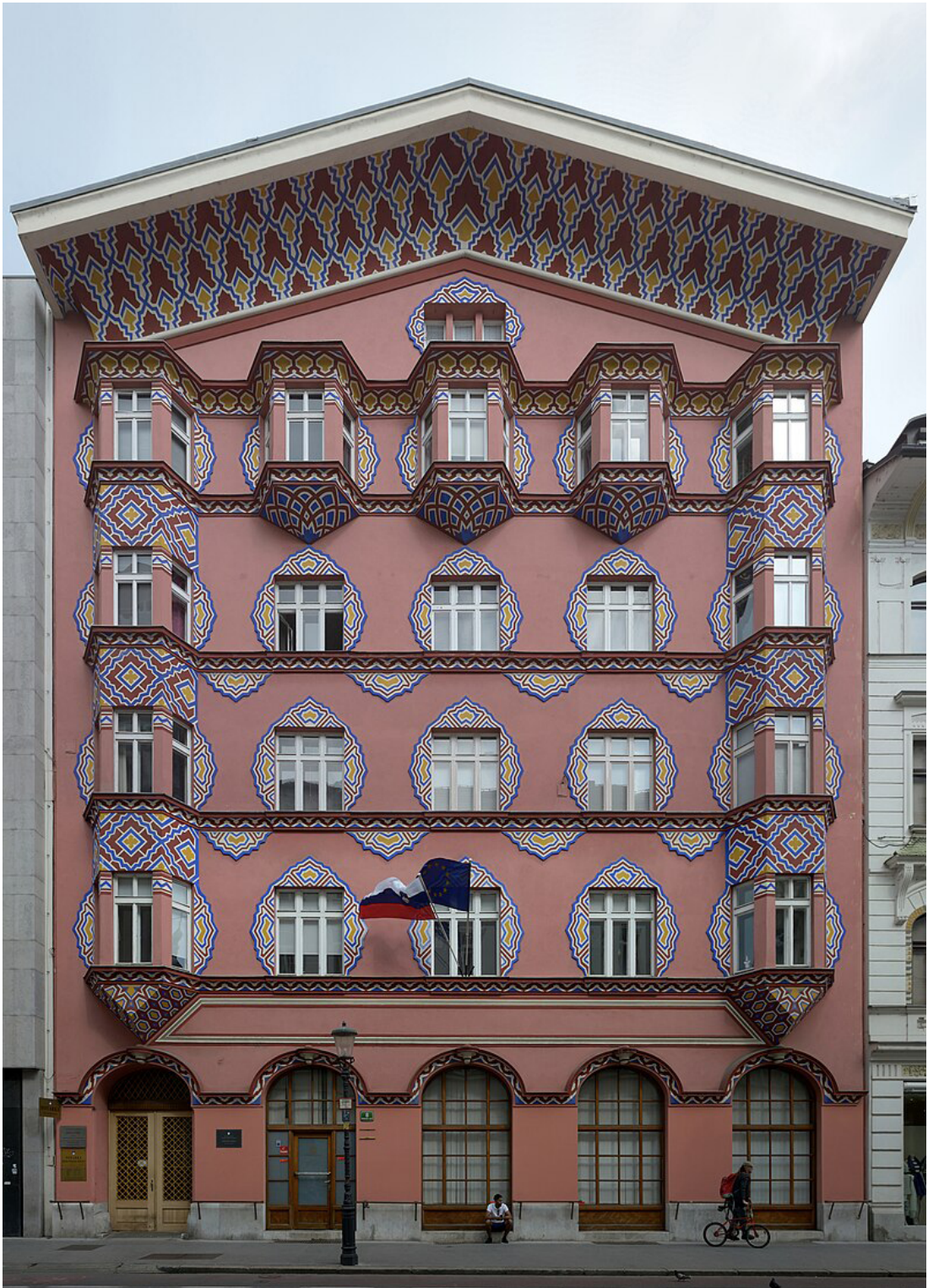
Abb. 1: Ivan und Helena Vurnik: Genossenschaftsbank Ljubljana (Gospodarska Banka), Hauptfassade, aktueller Zustand.
