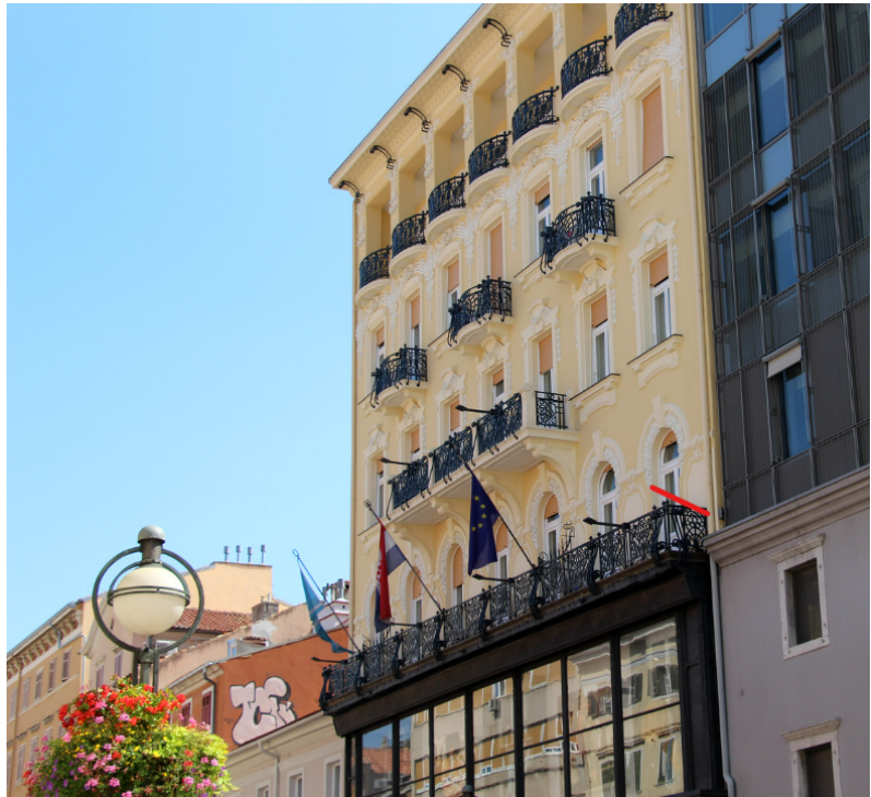
Abb. 8: Emilio Ambrosini: Haus Rauschel, Hauptfassade, aktueller Zustand.
