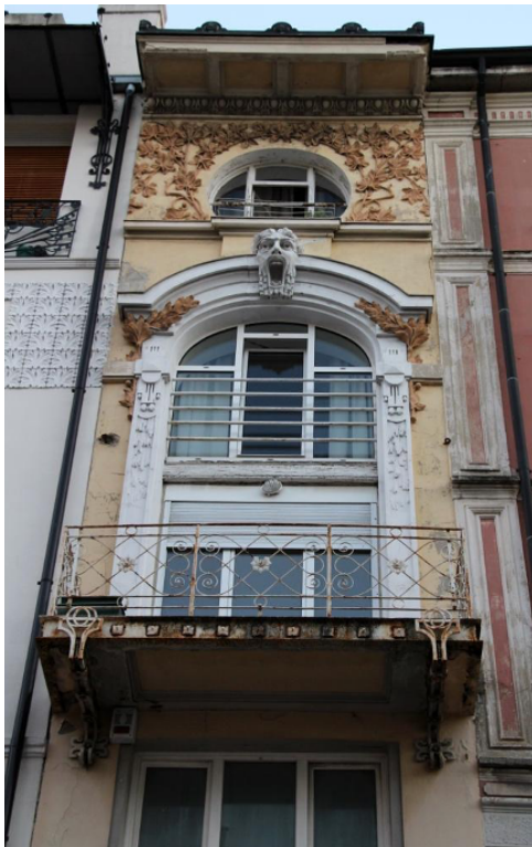
Abb. 6: Emilio Ambrosini: Haus Milcenich-Cerniak, Hauptfassade, aktueller Zustand.
