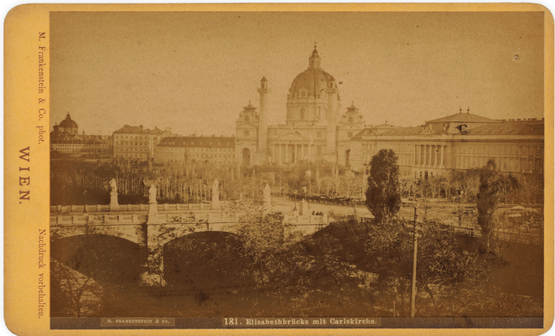
Abb. 4: Karlskirche mit Technischer Hochschule und Elisabethbrücke, Außenaufnahme, Albuminabzug, zwischen 1870 und 1890, Rijksmuseum Amsterdam.
