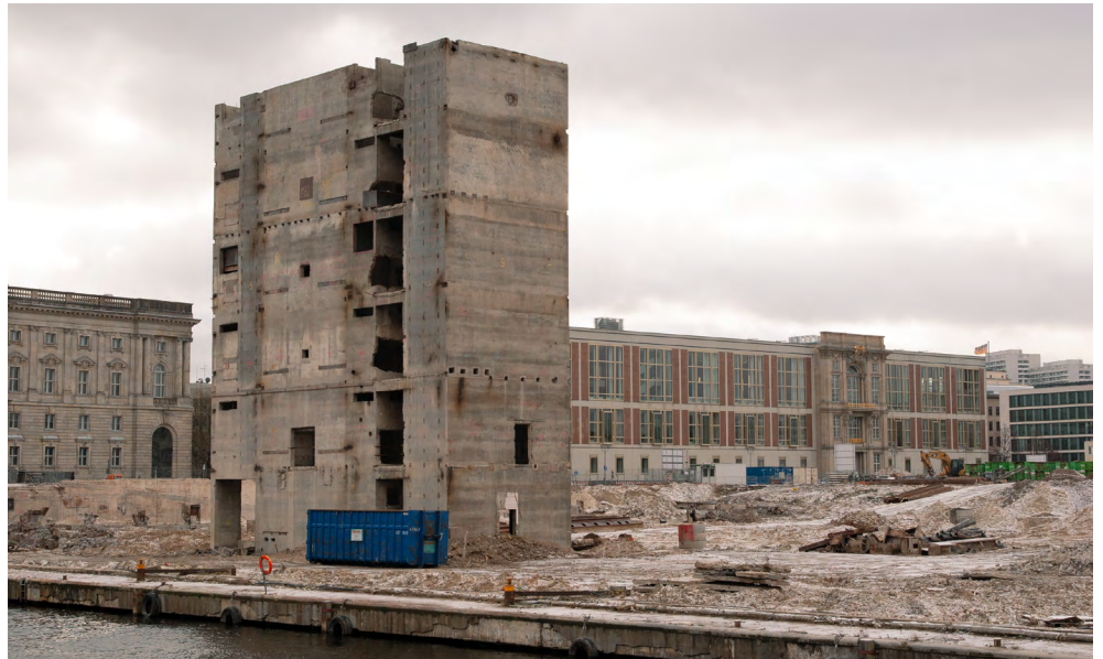
Abb. 1: Palastruine: Treppenturm des Palasts der Republik während der Abrissarbeiten © Heike Klussmann, 2006
