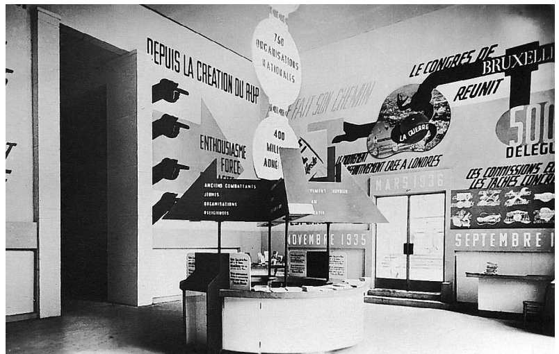
ABB. 24 Die der RUP gewidmete Ausgangshalle
