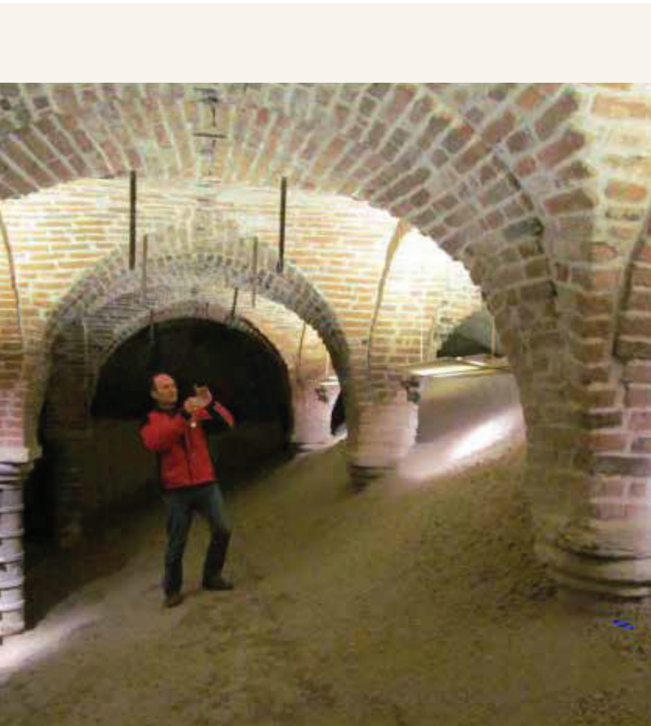
◀ Grundbruch im Stadtschloss Staufen – Flutung des Gewölbekellers zur Sicherung der Standfestigkeit des Gebäudes im Oktober 2012. Inv. Nr. BA 2020/3-2
