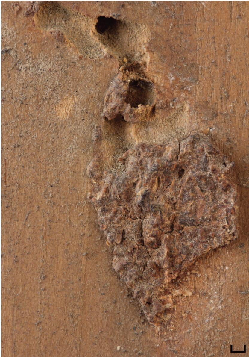
**Abb. 67** Kat. 6, Gm1807, Innenseite, Detail: Kittmasse im Bereich des ehemals montierten Reliefs
