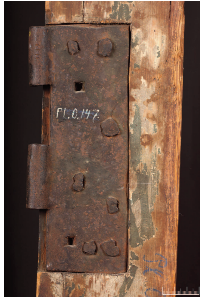
Abb. 27 Kat.22, Pl.O. 147, Rahmung, Detail Scharnierband mit gestanzten, viereckigen Löchern und originalen Nägeln
