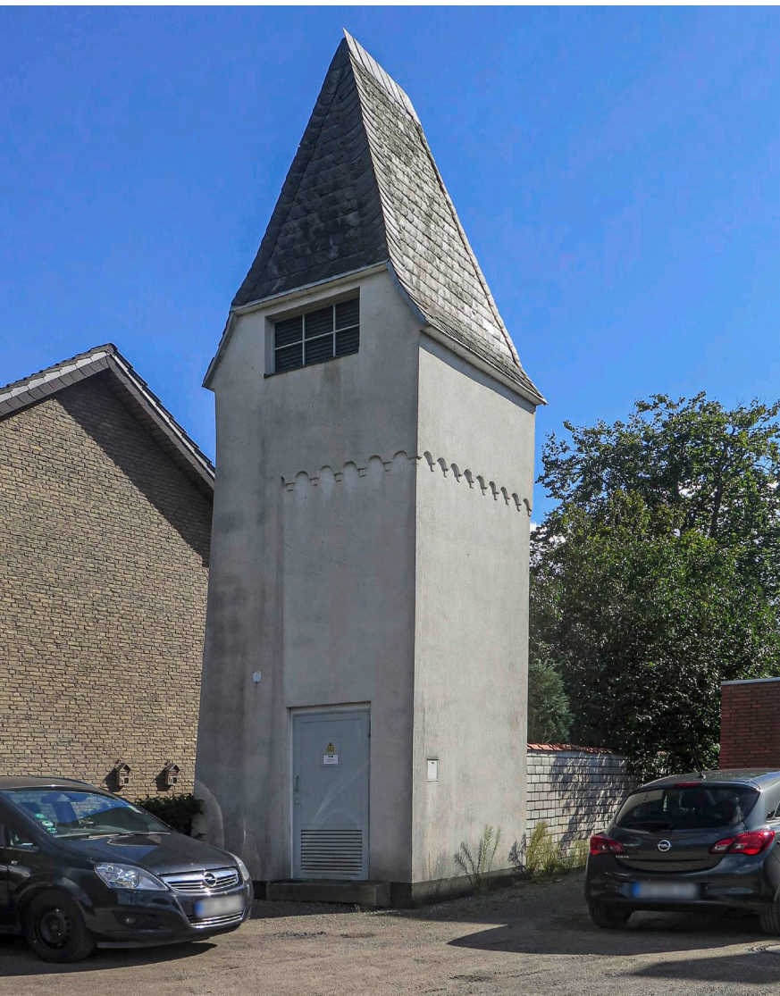
Abb. 2: Denkmalgeschützte Transformatorstation in Sendenhorst-Albersloh, Werseufer (2022).
