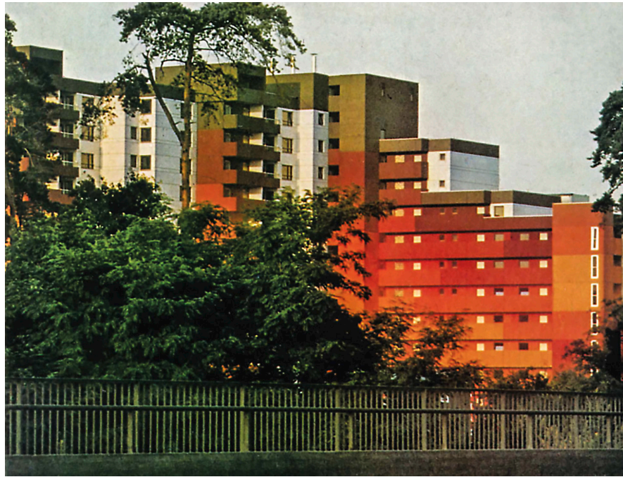
Abb. 2: Friedrich Ernst von Garnier, Wohnsiedlung, Griesheim bei Darmstadt, 1975.
