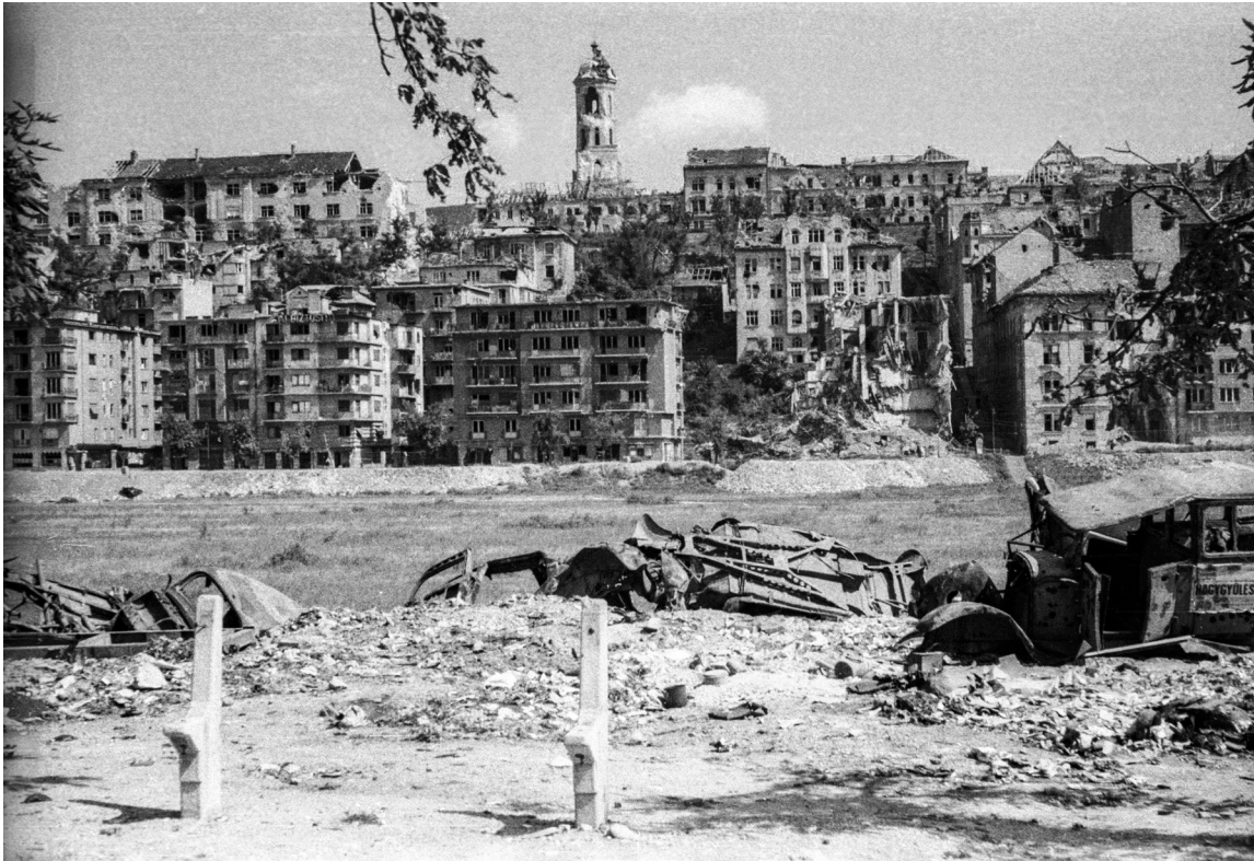
Abb. 3: Zwei Betonpfeiler – ohne Latten. Das Gebiet unter dem Budaer Burghügel, Vérmező, diente als provisorische Landebahn für Kampf- und Versorgungsflugzeuge 1944/45 und wurde bei der Schlacht um Budapest 1945 zu einer Trümmerlandschaft. Im Jahr 1947 begann die Landschaftsgestaltung des Gebiets – und so bekamen auch die Betonpfeiler wieder rote Latten. Ungarn, Budapest, Vérmező, (1945).
