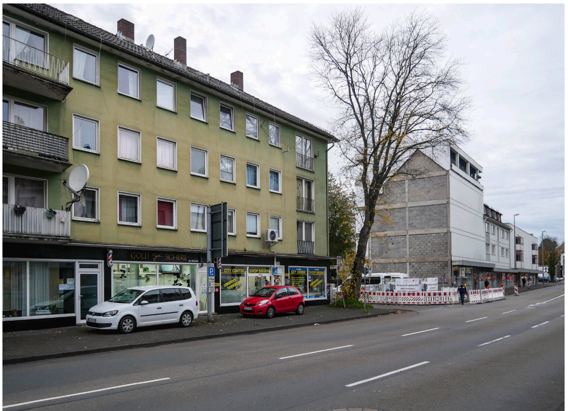
Abb. 3: Weidenauer Straße in Siegen nach dem Abbruch des Deutschen Hauses, November 2022.
