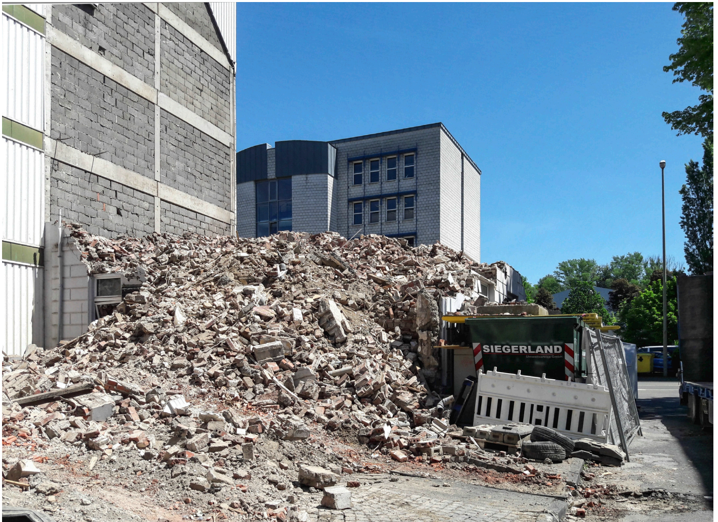
Abb. 2: Weidenauer Straße in Siegen während des Abbruchs im Juni 2021.
