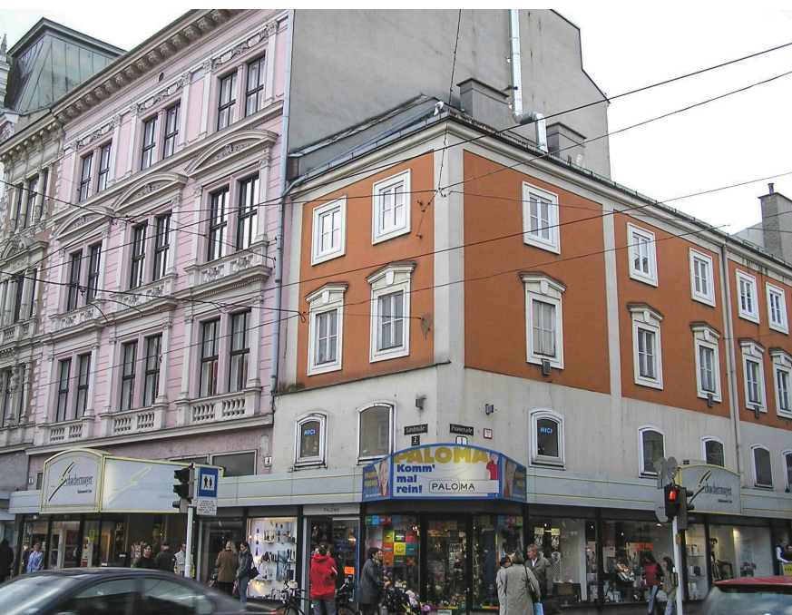
Abb. 3: Oberösterreich, Linz, Landstraße 2006.
