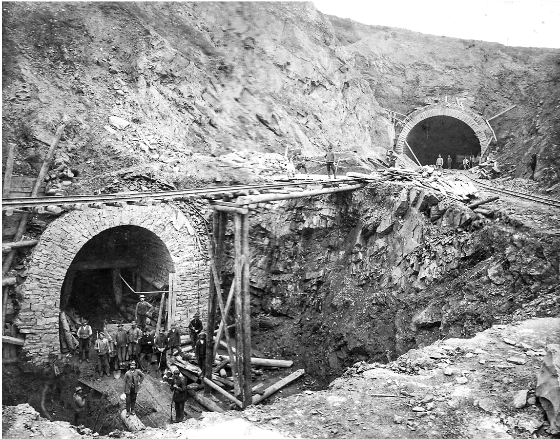
Abb. 3: Die Nordportale des Giersbergtunnels im Bauzustand (um 1912/13).
