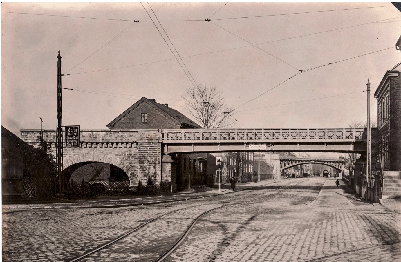
Abb. 2: Die Brücken über die Hagener Straße (vermutlich nach 1915).
