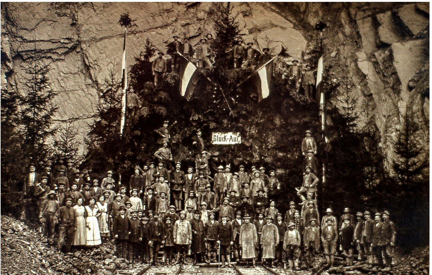
Abb. 4: Erinnerung an den Durchschlag des Rudersdorfer Tunnels (März 1913).
