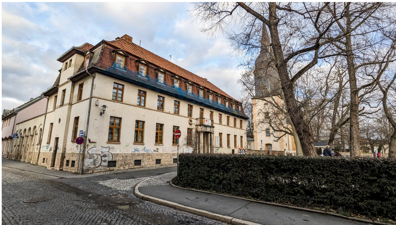
Abb. 2: Das ehemalige Arbeitsamt neben dem Jakobskirchhof im Jahr 2023. Der gemeinsame Entstehungskontext des Ensembles ist heutzutage vergessen. Stattdessen ist der Bau der öffentlichen Wahrnehmung nahezu vollkommen entzogen.
