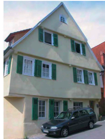
Verputztes Gebäude Kirchbergstraße
