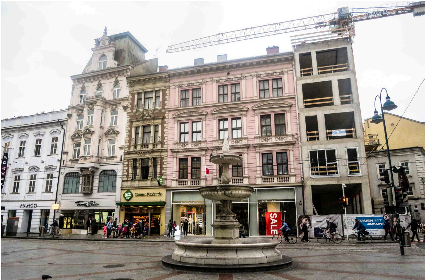
Abb. 4: Oberösterreich, Linz, Landstraße 2016.
