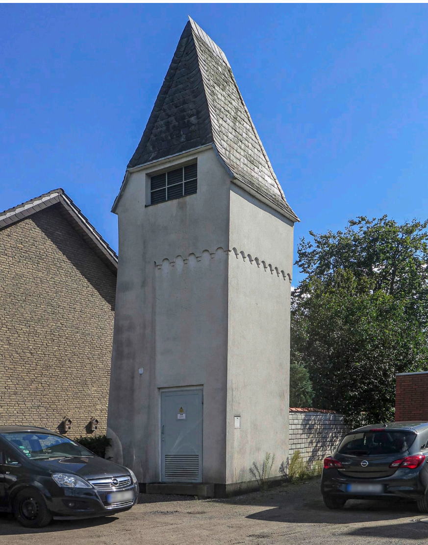
Abb. 2: Denkmalgeschützte Transformatorstation in Sendenhorst-Albersloh, Werseufer (2022).
