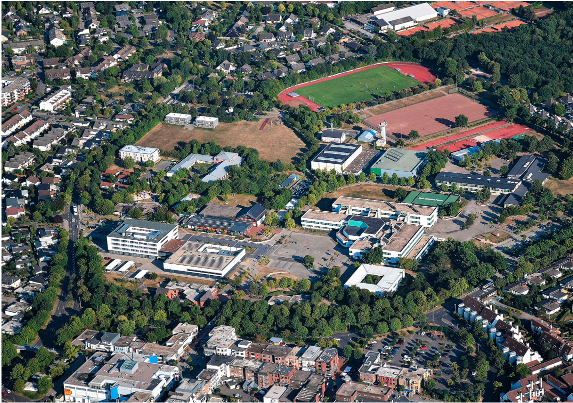
Abb. 4: Luftbild des Schulzentrums (2022).
