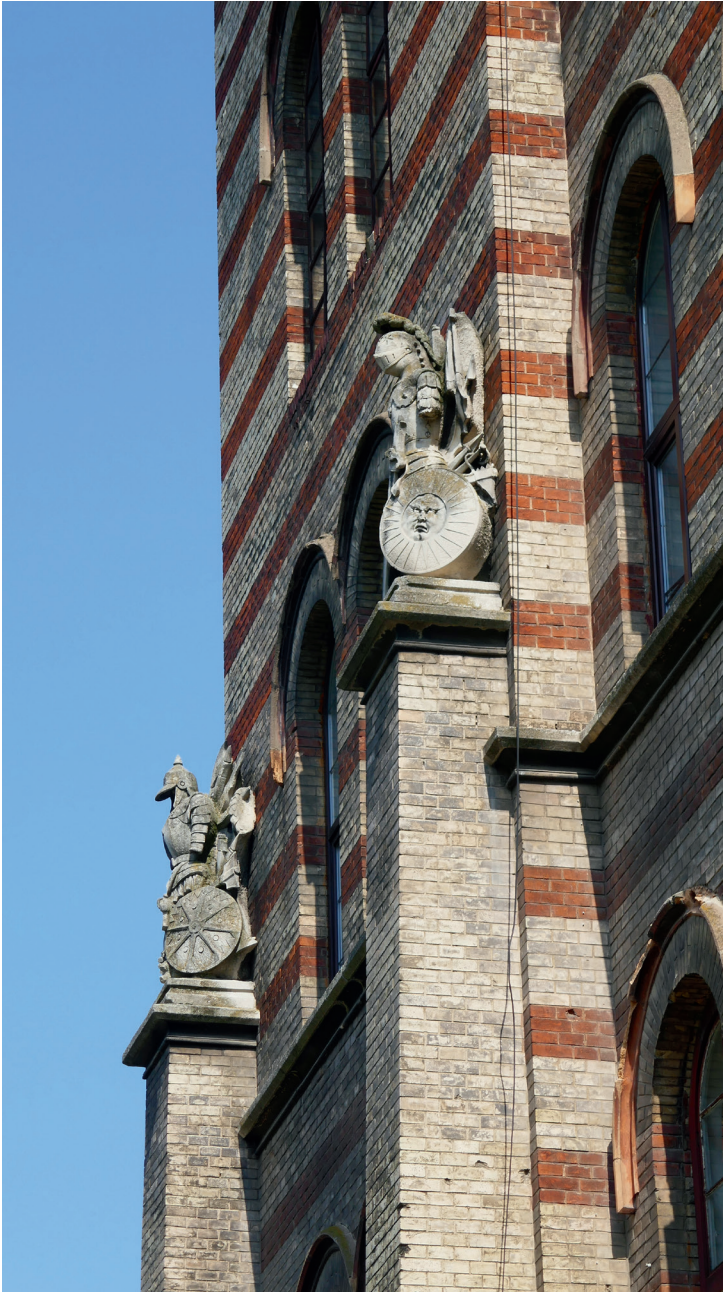
Abb. 8 k.k. Invalidenhaus, Lemberg: Trophäen an der Fassade, Foto Areta Kovalska
