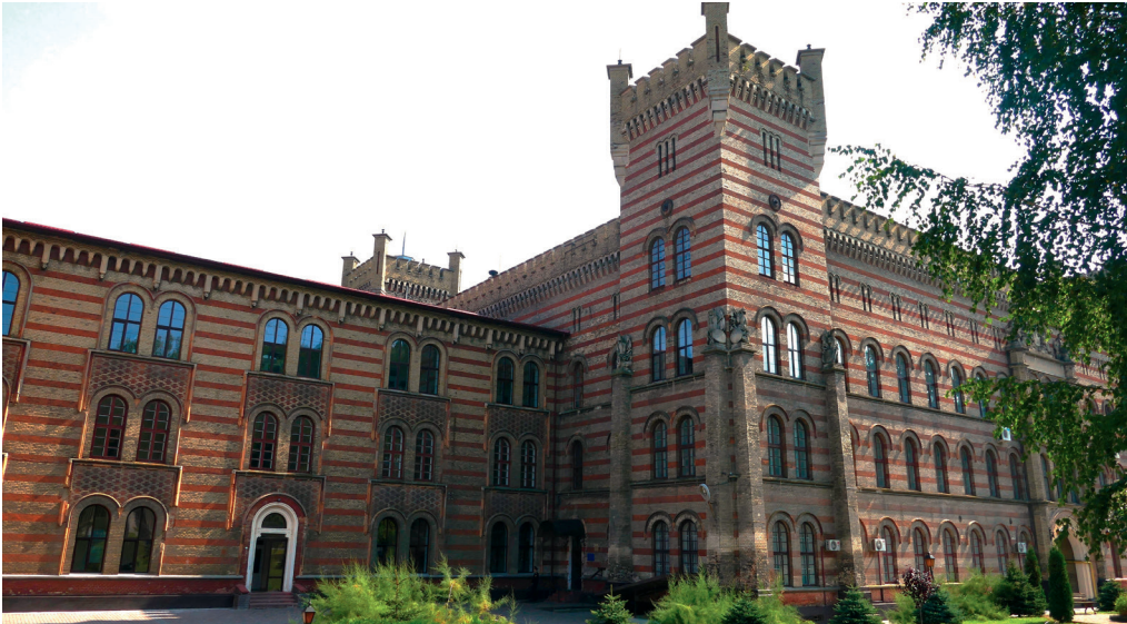
Abb. 6 k.k. Invalidenhaus, Lemberg: Details der rückwärtigen Fassadengestaltung, Foto Areta Kovalska.
