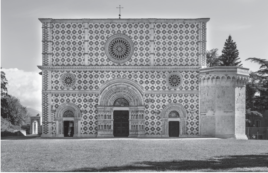
Abbildung 28: Fassade S. Maria di Collemaggio, L'Aquila
