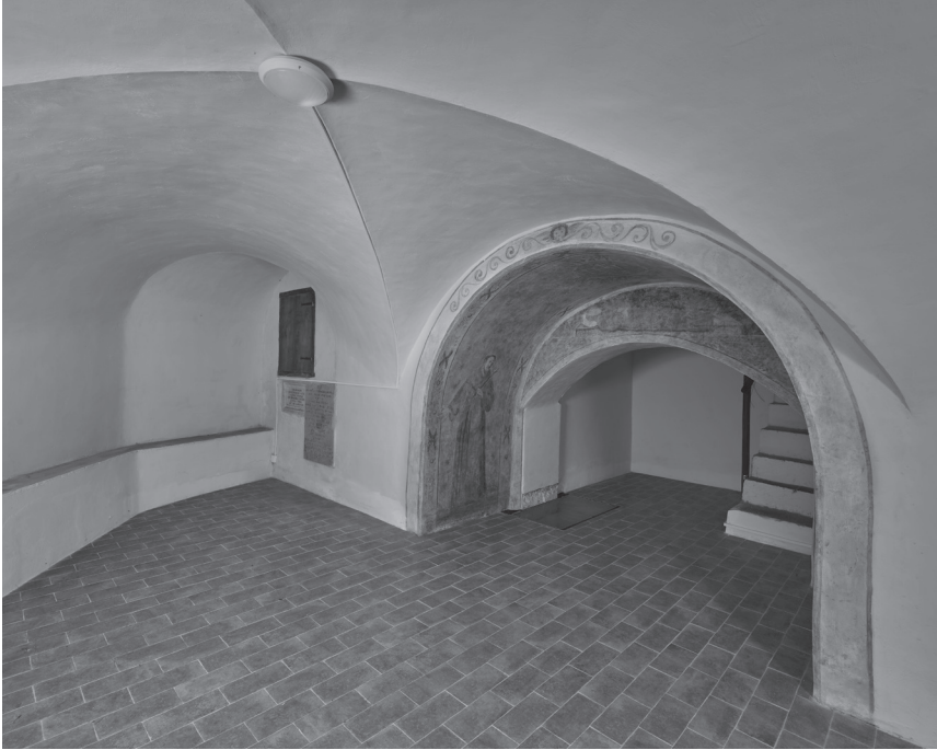
Abbildung 40: Südl. Kryptabereich Bernhardinkapelle mit Verschlussklappe zum Gruftraum
