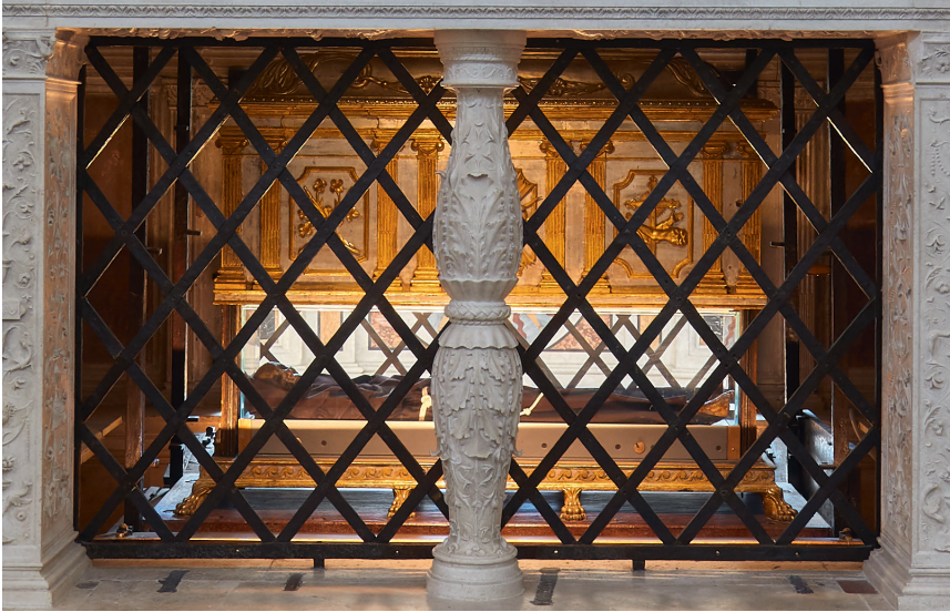
Abbildung 89: Bernhardinmausoleum, Vergitterung der vorseitigen Öffnung
