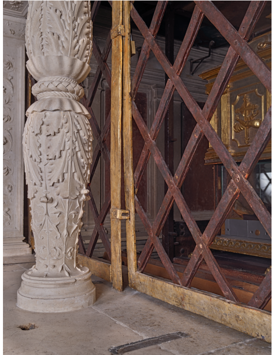
Abbildung 90: Bernhardinmausoleum, Vergitterung der rückseitigen Öffnung mit Firnisresten
