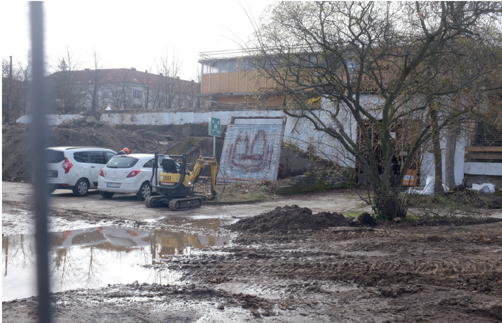
[15] Abgebaute Leuchtreklame auf der Baustelle des ehemaligen Restaurants »Minsk«
