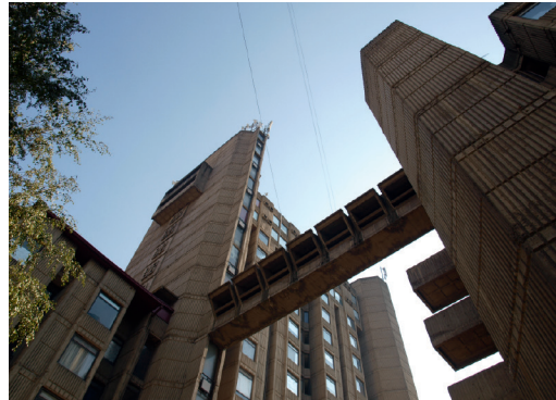
[2] Beim Goce Delčev Studentenhaus von Gjorgji Konstantinovski, 1971–1975, verbinden Brücken die Wohntürme und gemeinschaftlichen Dachterrassen
