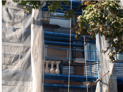
[5] Neoklassizistische Fassadenverkleidung wird im Rahmen des Programms Skopje 2014 an einem Wohnhaus der Nachkriegszeit angebracht.
