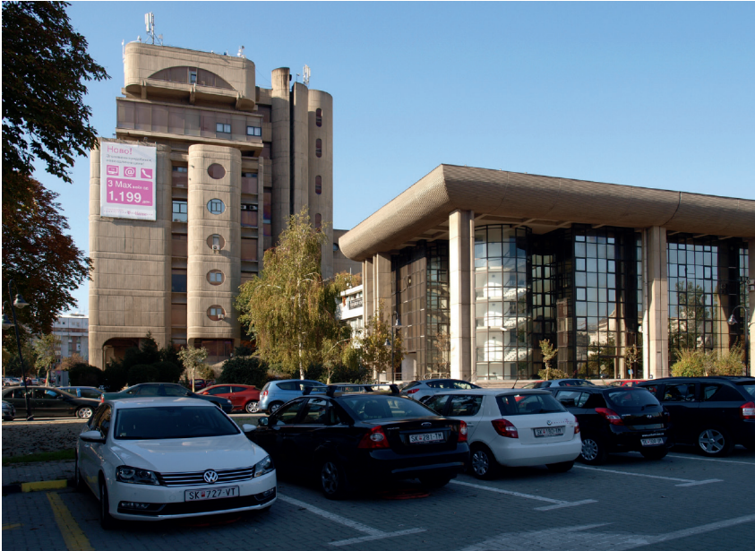
[3] Das Post- und Telekommunikationsgebäude von Janko Konstantinov, 1974, ist eine organische, brutalistische Skulptur (links). Die Schalterhalle wurde 2013 durch ein Feuer und der Gebäudeteil rechts von Architekt: Zoran Štaklev im Rahmen von Skopje 2014 zerstört.
