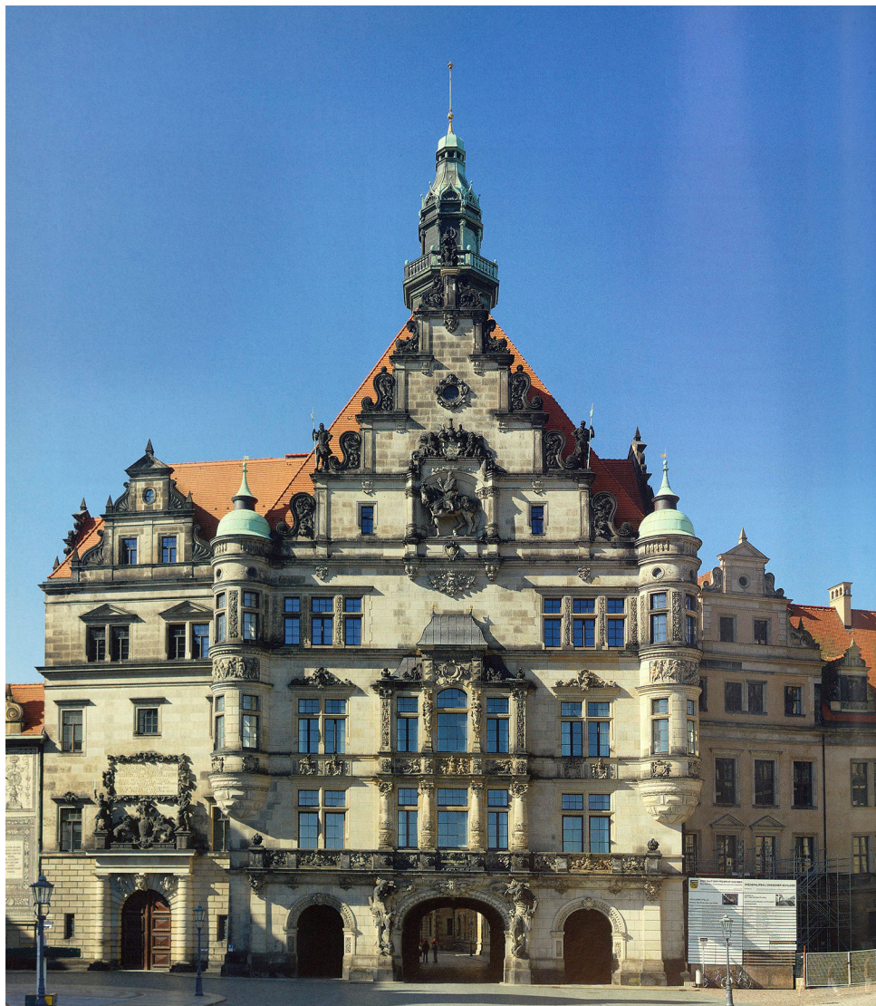
Fig. 79. Dresda, Residenzschloss, Georgenbau (la facciata esterna è tardo-ottocentesca)
