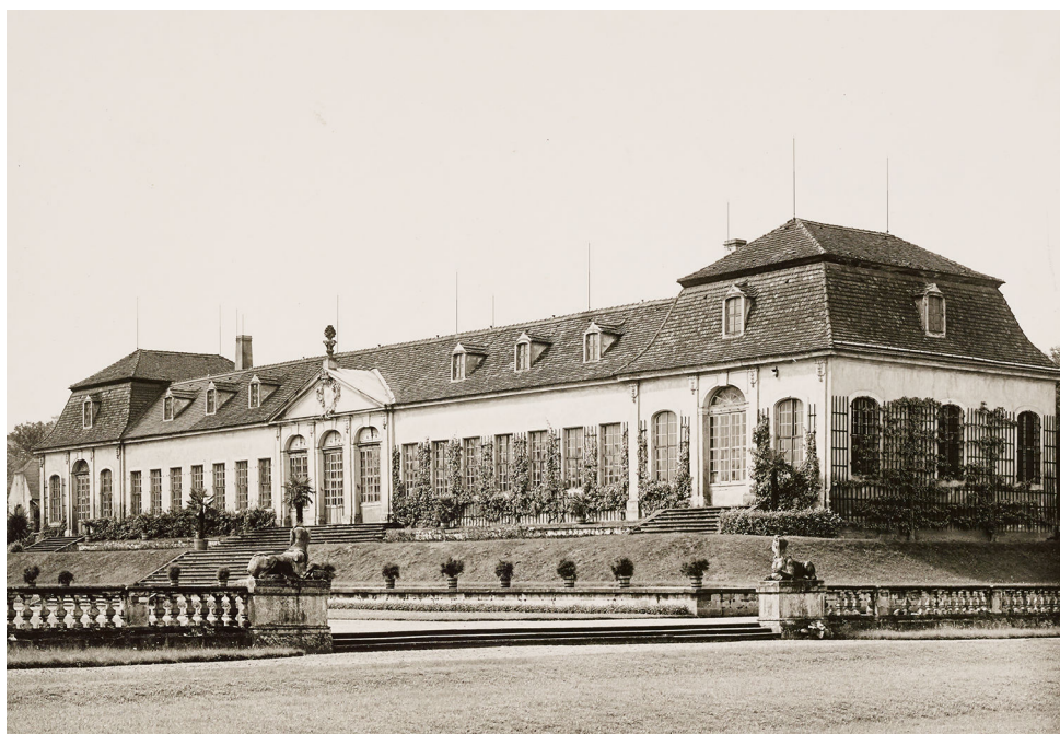
Fig. 94. Johann Christoph Knöffel, Matthäus Daniel Pöppelmann, Zacharias Longuelune, Giardino barocco e citroniera a Großsedlitz, inizio dei lavori 1719
