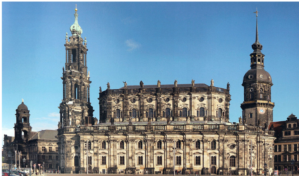
Fig. 66. Gaetano Chiaveri, Chiesa di corte di Dresda, 1736-1749, veduta da nord-ovest
