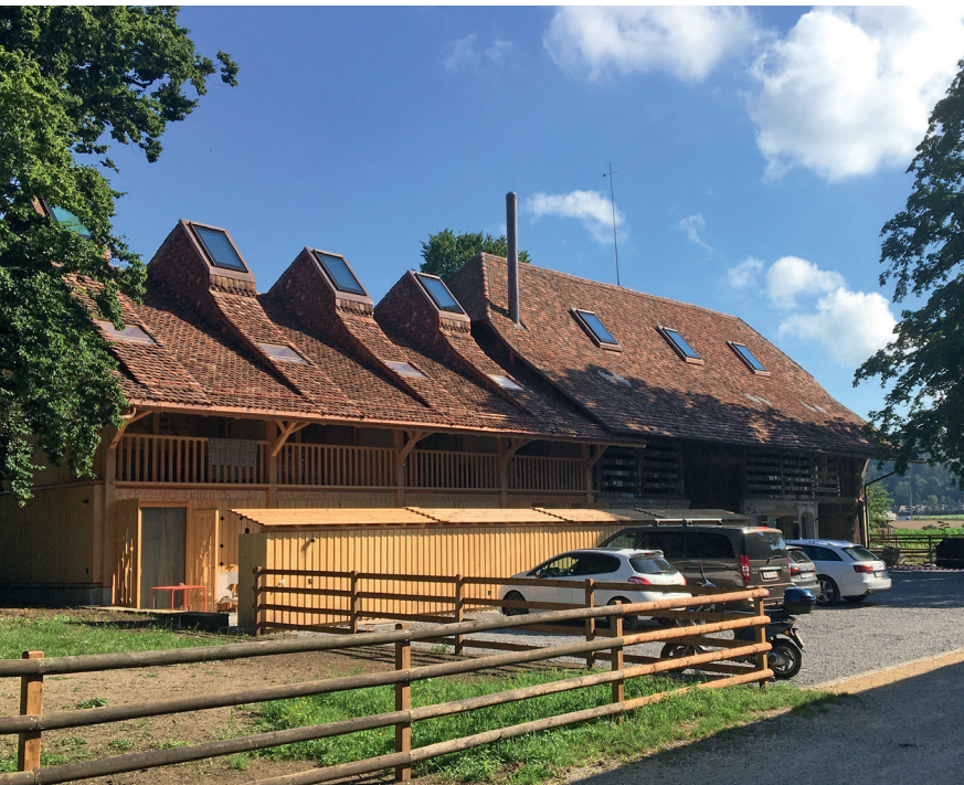
Abb. 2: Der Westanbau der „inneren Scheune“ des Schlosses Wittigkofen bei Bern: der Altbau, genutzt als Lagerraum (2017) und nach Abbruch und Neubau zu Wohnzwecken (2020).
