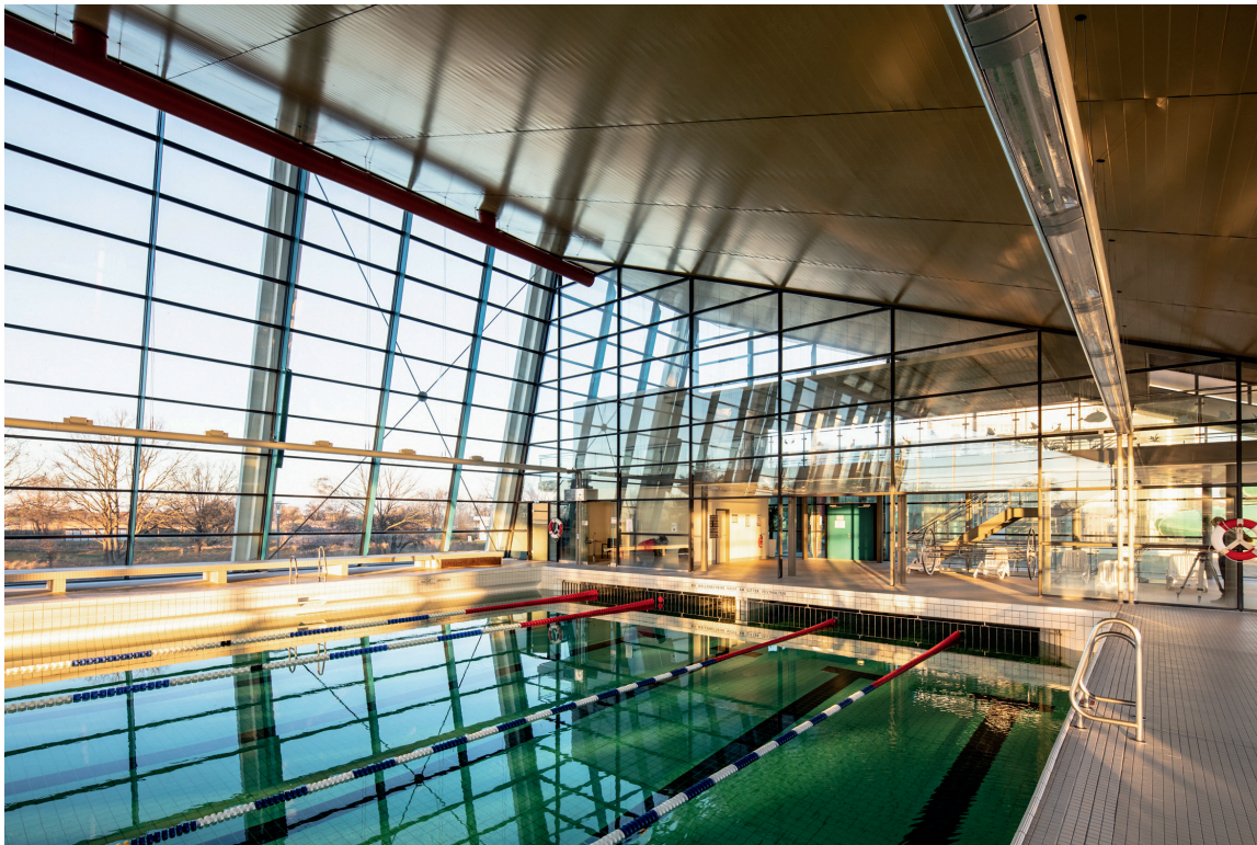
Abb. 2: Meerwasserwellenband, Burgtiepe auf Fehmarn, Innenansicht mit Blick zum ehemals voll verglasten Foyer und „Erfrischungsraum“ im Obergeschoss.
