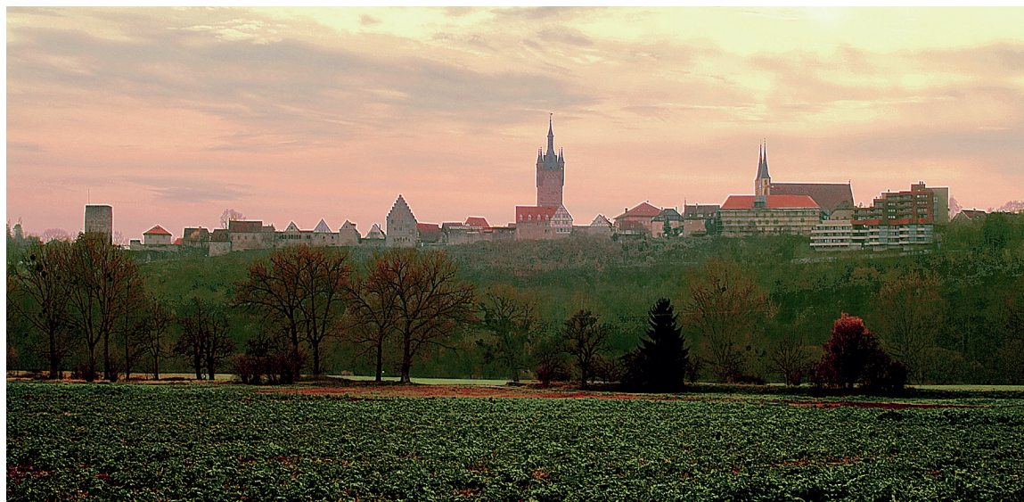
Abb. 1: Der blaue Turm in Bad Wimpfen ist eine Landmarke und von überregionaler Bedeutung. Ihn zu retten war in jeder Hinsicht eine Herausforderung. (2007)
