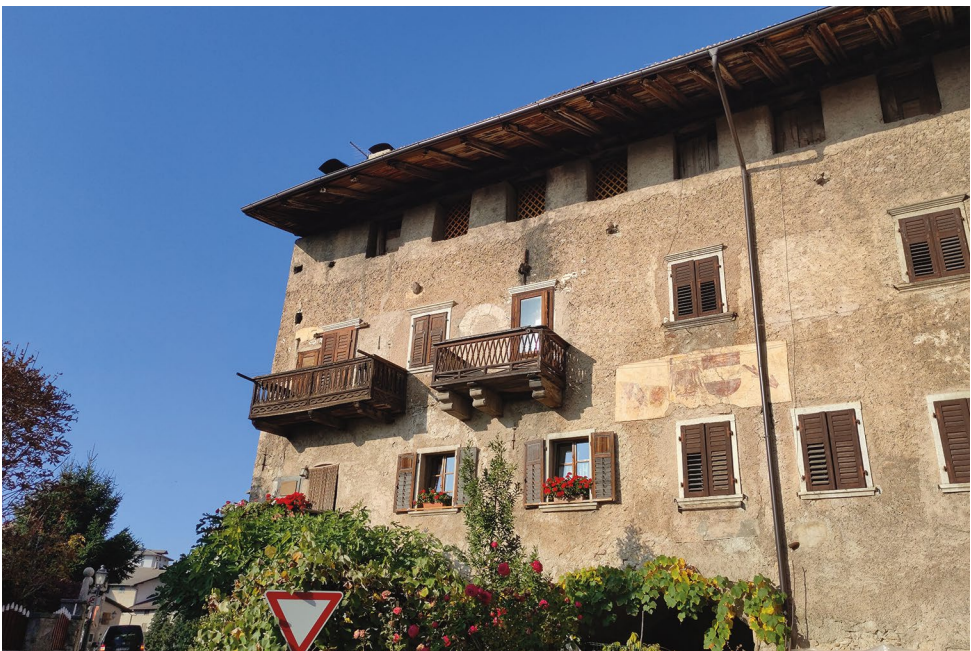
Abb. 206 Coredo, Palazzo Nero, südliche Außenseite
